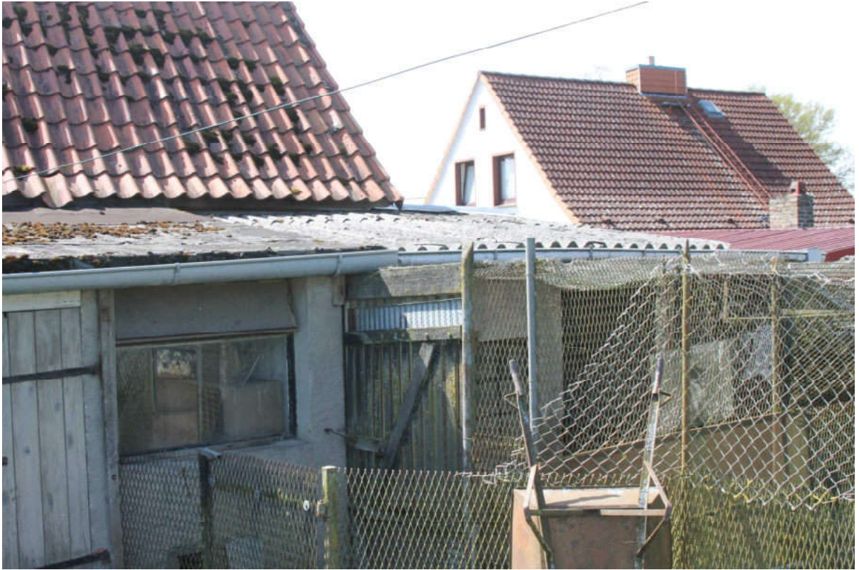
Bild 43: Rückfront des Nebengebäudes
