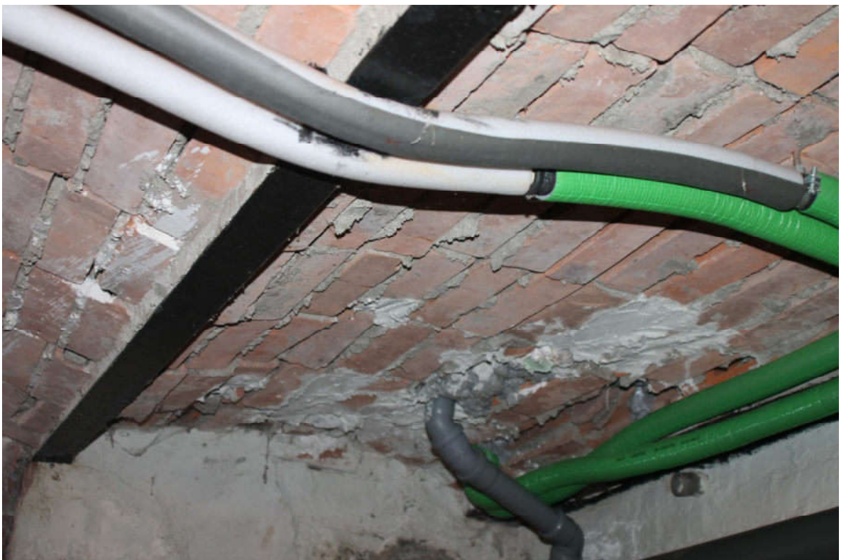
Bild 24: Blick auf die Kellerdecke
