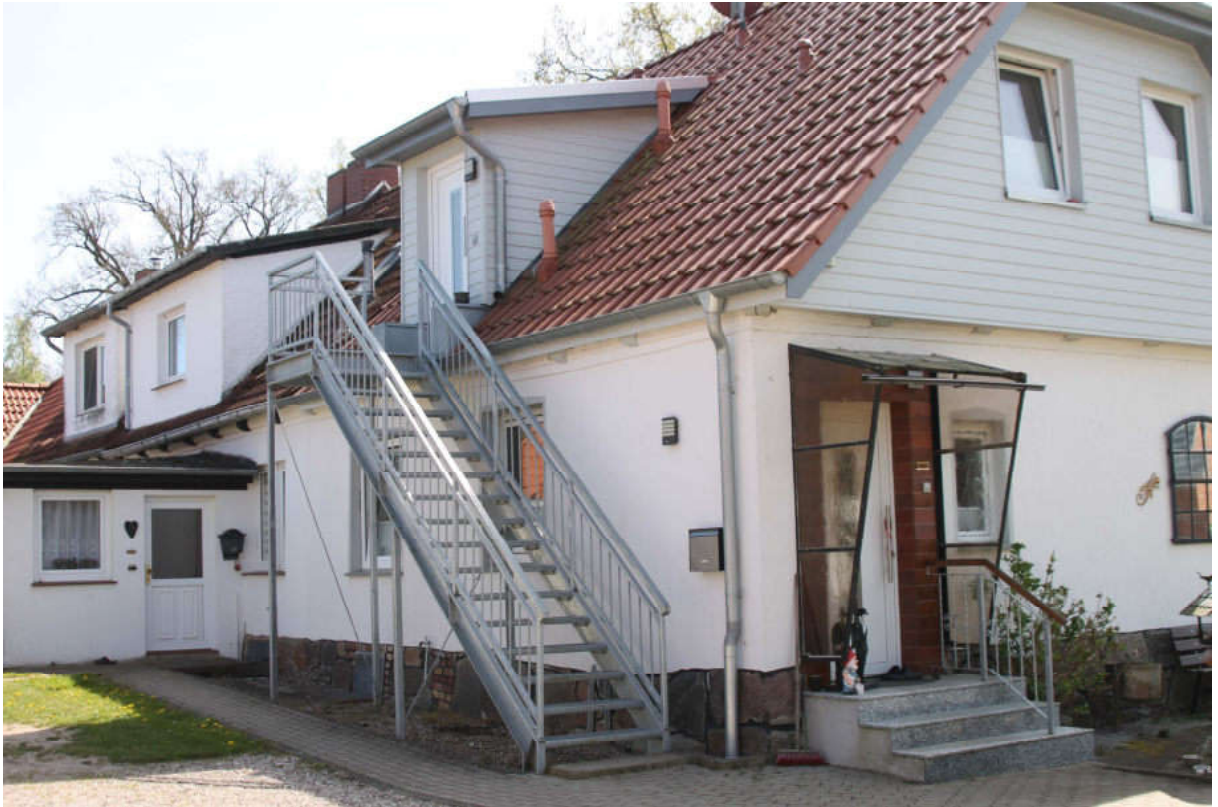
Bild 5: Zugang zur Wohneinheit im Dachgeschoss über die hofseitige Außentreppe
