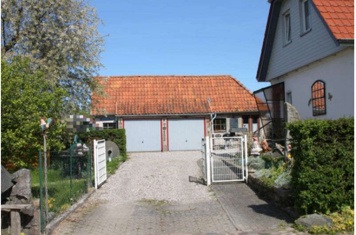
Bild 3: Sicht auf die Zufahrt zum Grundstück, im Hintergrund das Nebengebäude
