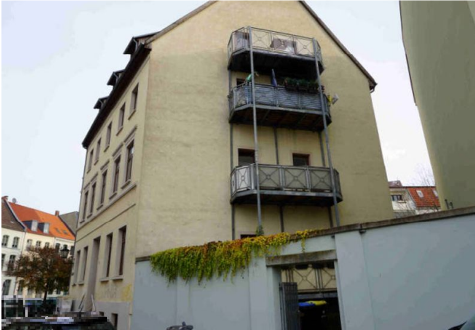
↑ Bild 3: Südwestgiebel mit Balkonanlage
