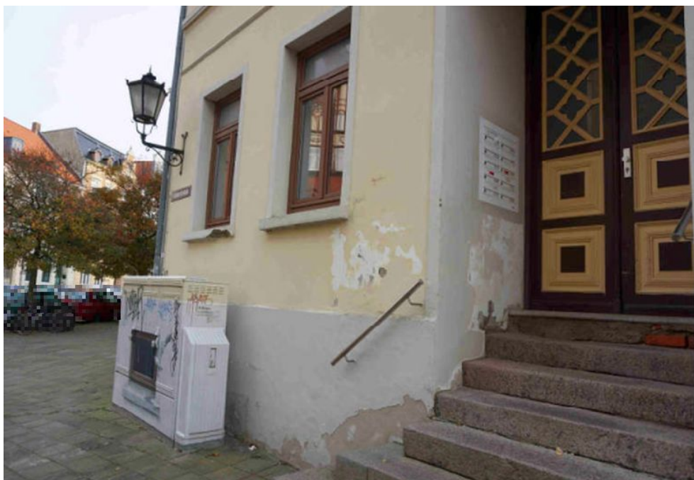
↑ Bild 2: Eingangsbereich des Mehrfamilienwohnhauses
