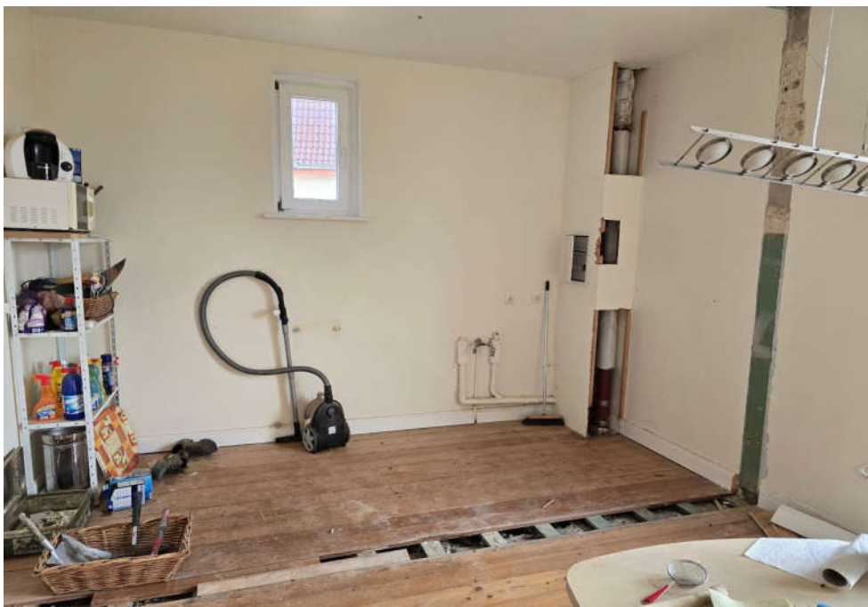
↑ Bild 26: im Umbau befindliche Küche
