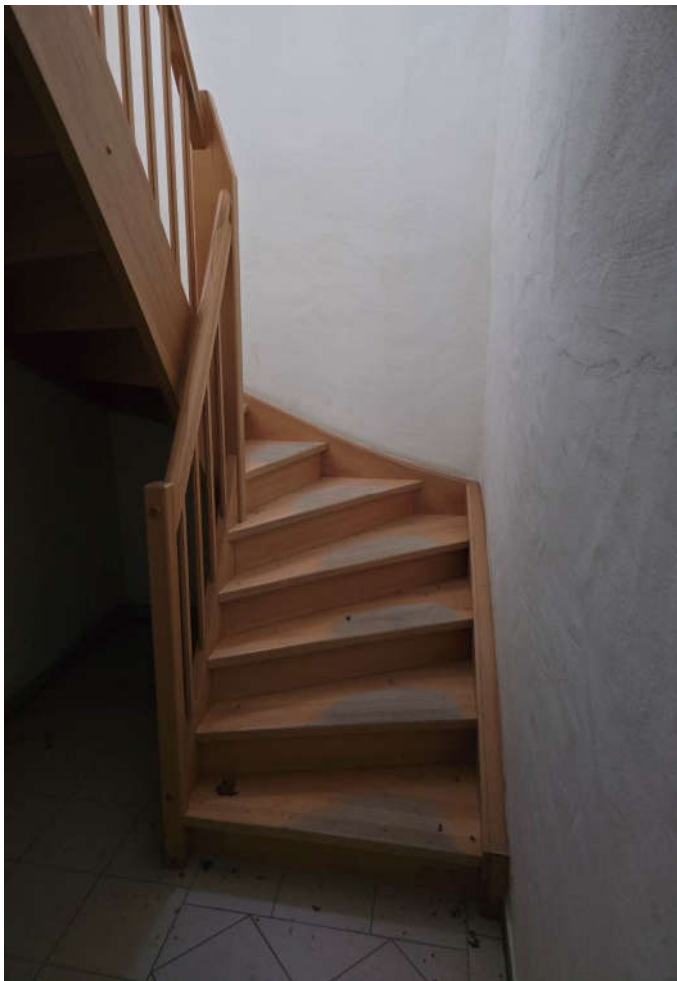
↑ Bild 16: Treppe zum Erdgeschoss
