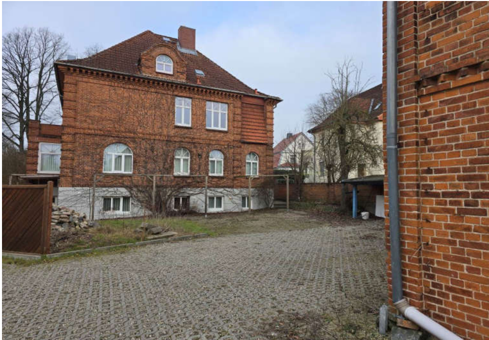
↑ Bild 5: Hofffläche und Südansicht des Wohngebäudes
