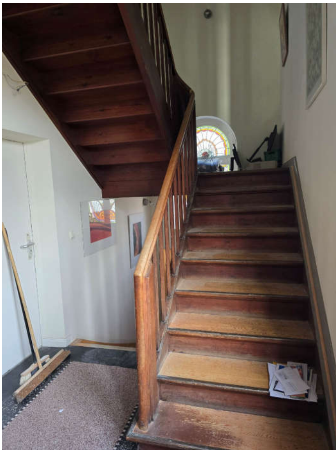
← Bild 24: Treppe zum Obergeschoss
