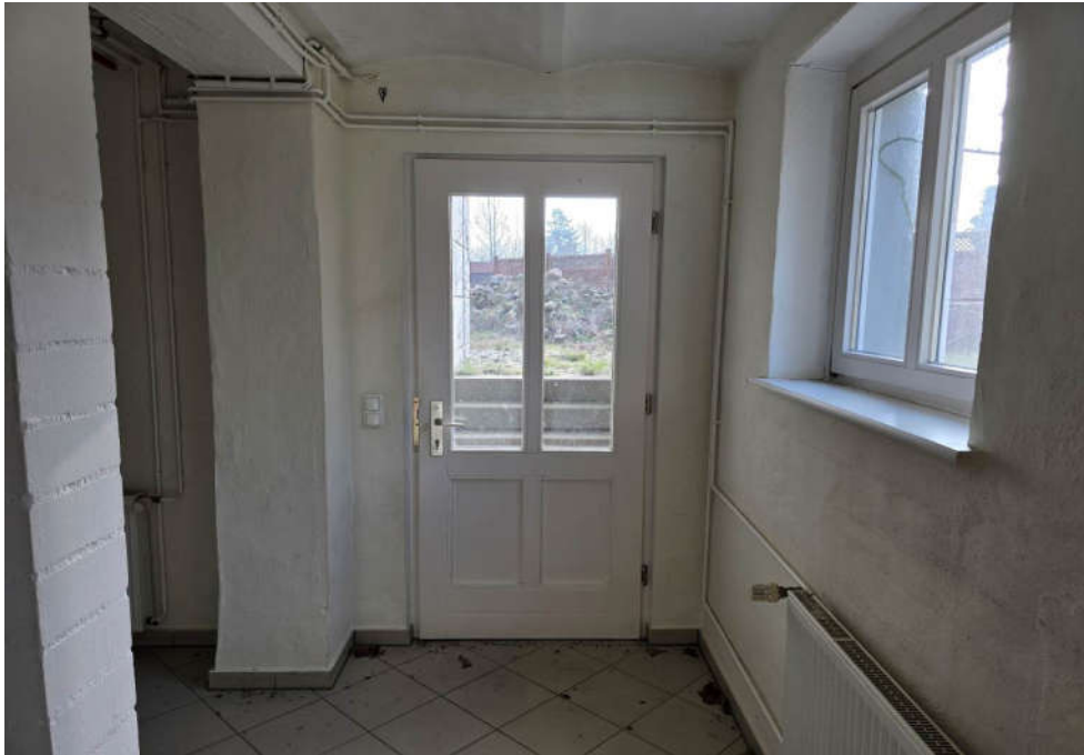
↑ Bild 13: Tür zur Kelleraußentreppe
