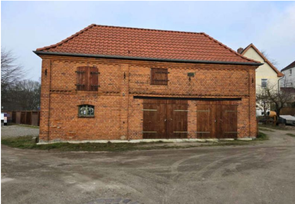
↑ Bild 7: Südseite des ehemaligen Wirtschaftsgebäudes
