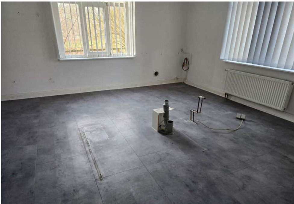
↑ Bild 20: ehemaliges Büro/Dentallabor im Erdgeschoss
