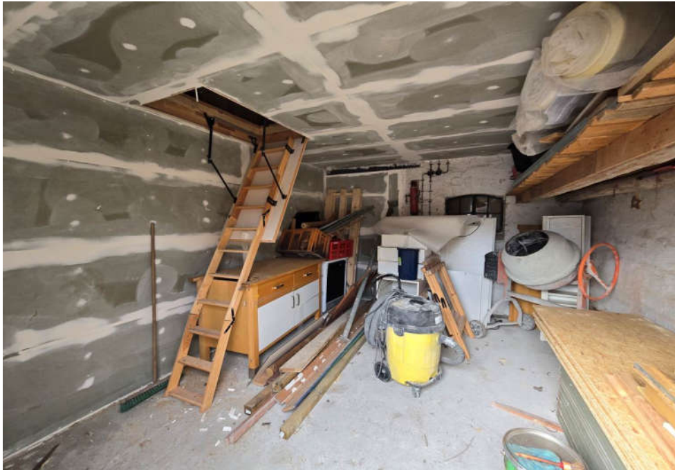
↑ Bild 35: Blick in eine Garage im ehemaligen Wirtschaftsgebäude
