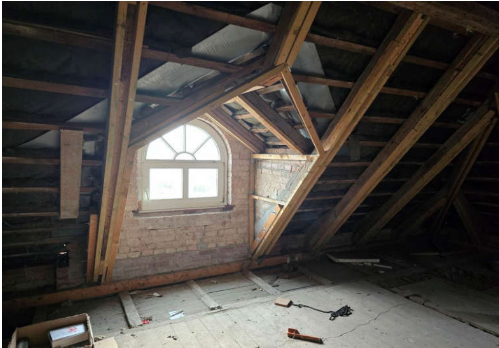
↑ Bild 31: Gaube im Dachgeschoss
