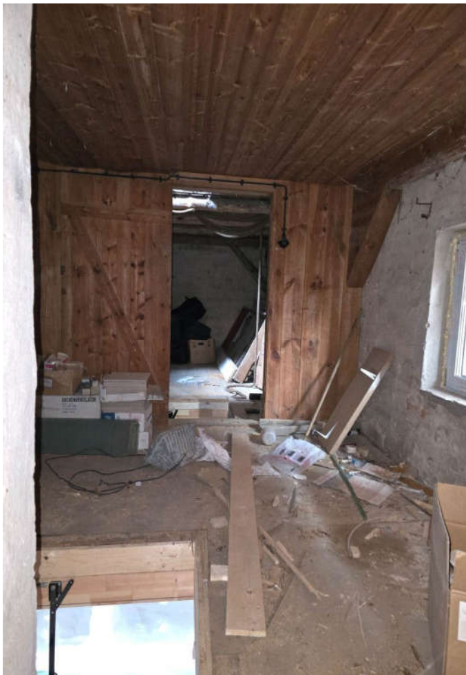
↑ Bild 36: Drempeigeschoss im ehemaligen Wirtschaftsgebäude
