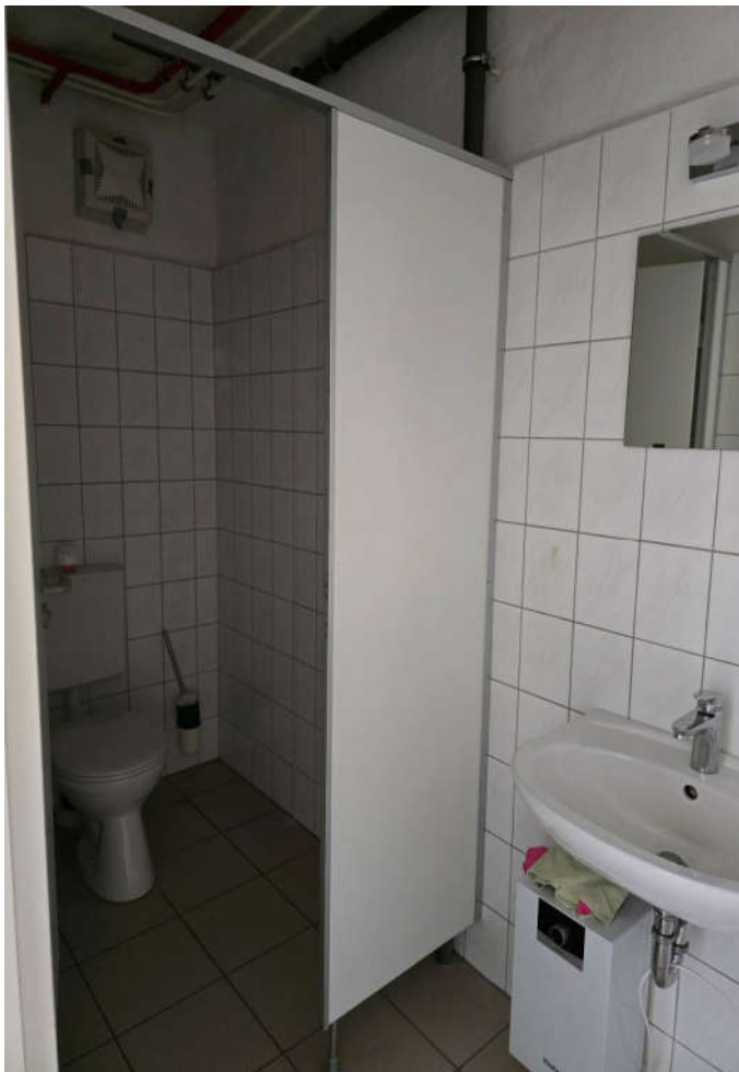
↑ Bild 14: Sanitärbereich im ehemaligen Dentallabor im Kellergeschoss
