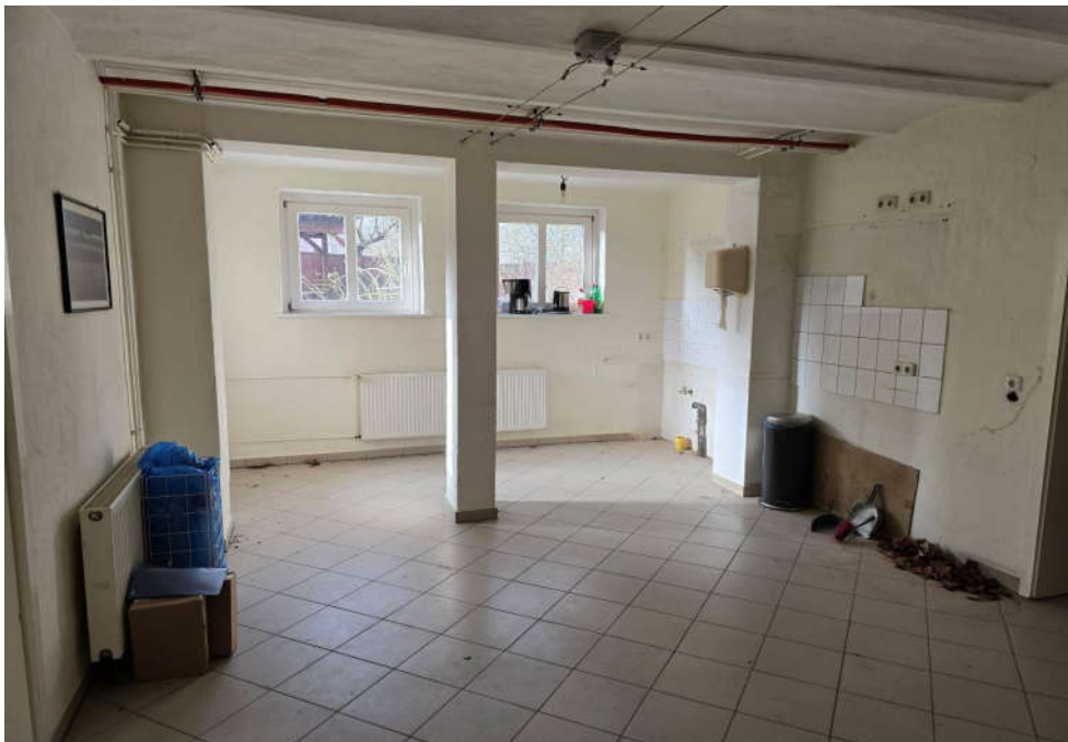
↑ Bild 12: ehemaliges Dentallabor im Kellergeschoss
