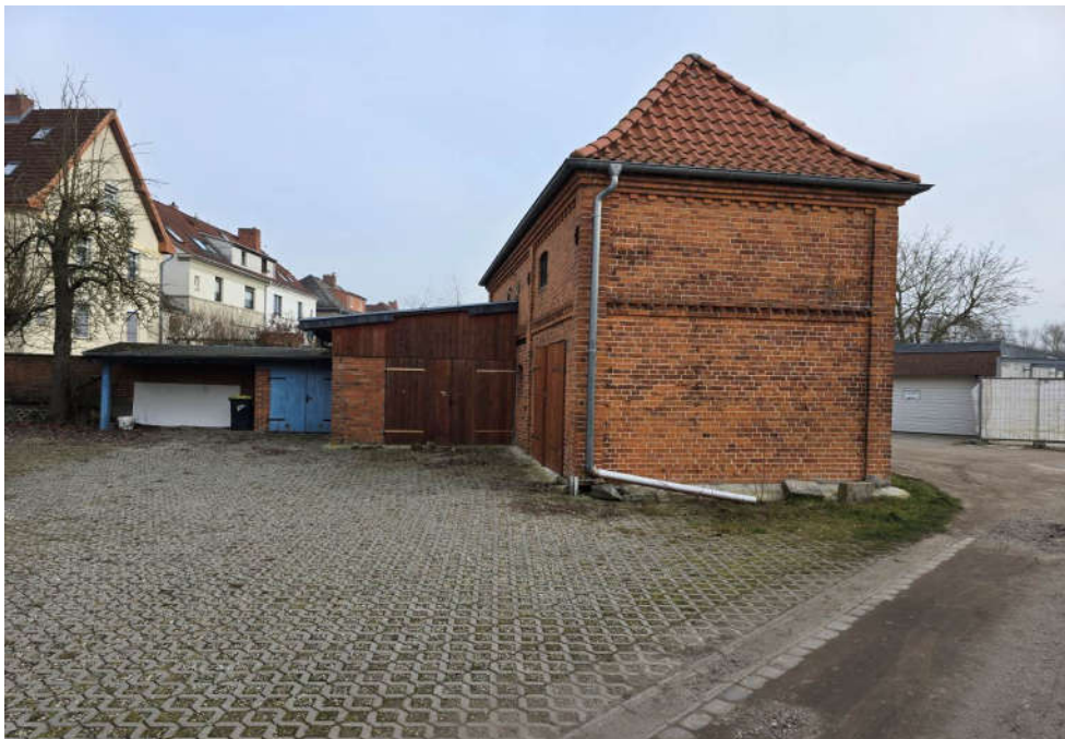
↑ Bild 6: Nebengebäude an der südlichen Grundstücksgrenze
