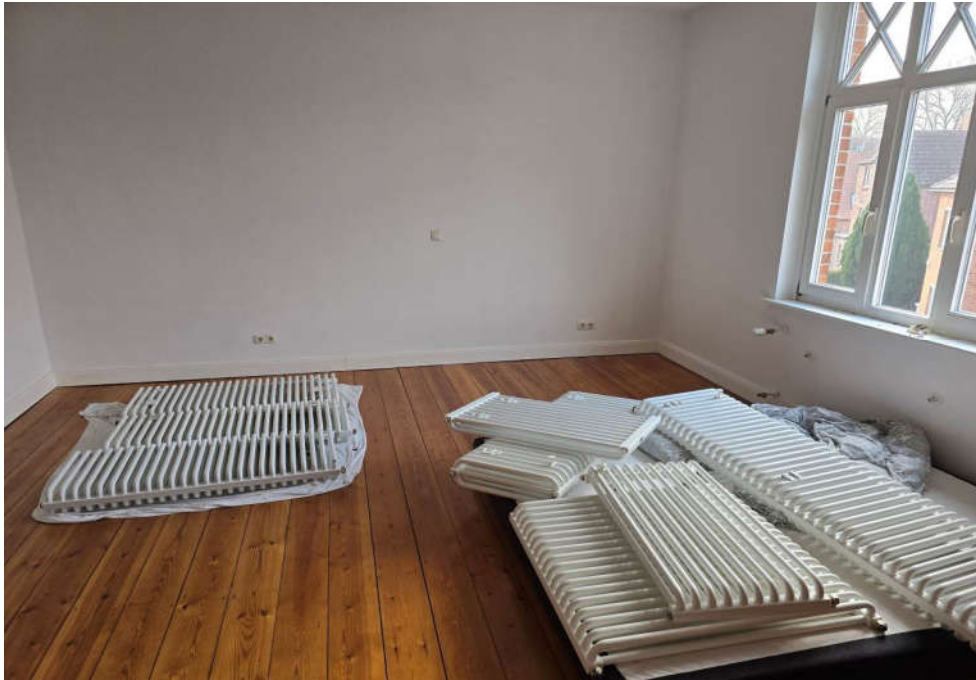
↑ Bild 29: demontierte Heizkörper
