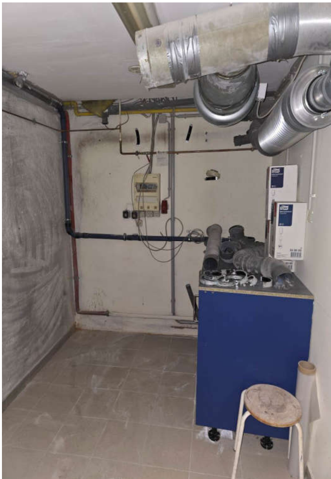
↑ Bild 10: ehemaliges Dentallabor im Kellergeschoss
