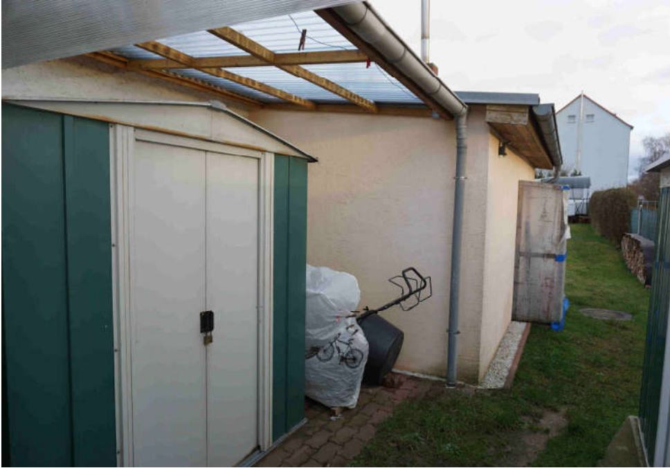
↑ Bild 7: Schuppen und Anbau an der Südseite
