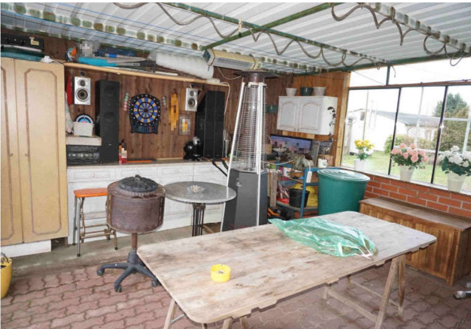
↑ Bild 6: Südlicher Bereich des Carports
