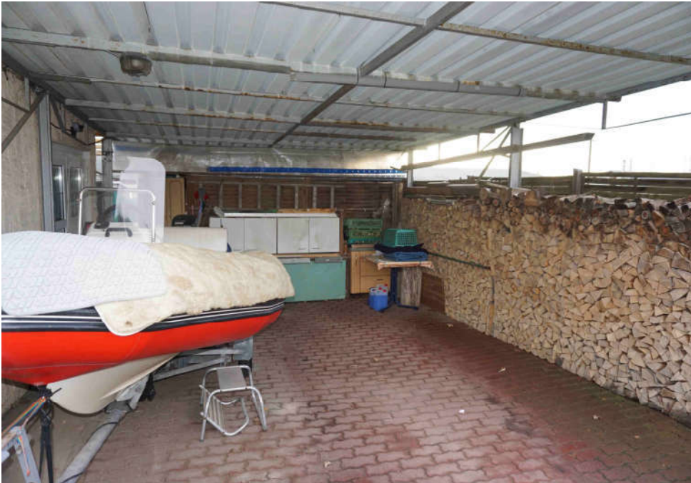
↑ Bild 5: Carport am Westgiebel
