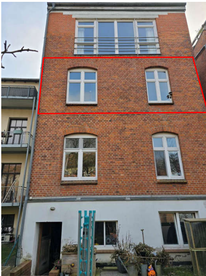
↑ Bild 2: Hofansicht des Wohngebäudes mit Kennzeichnung des Bewertungsobjektes
