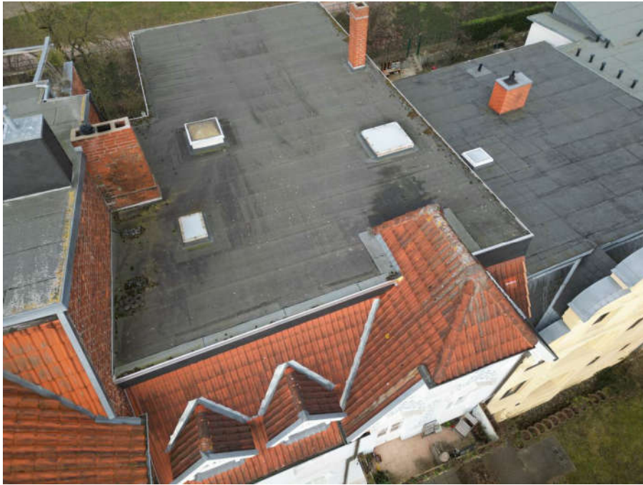
↑ Bild 19: Drohnenaufnahme von der Dachfläche
