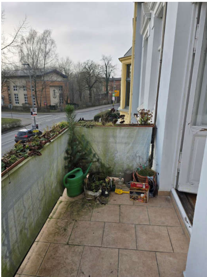
← Bild 16: Blick auf den Balkon
