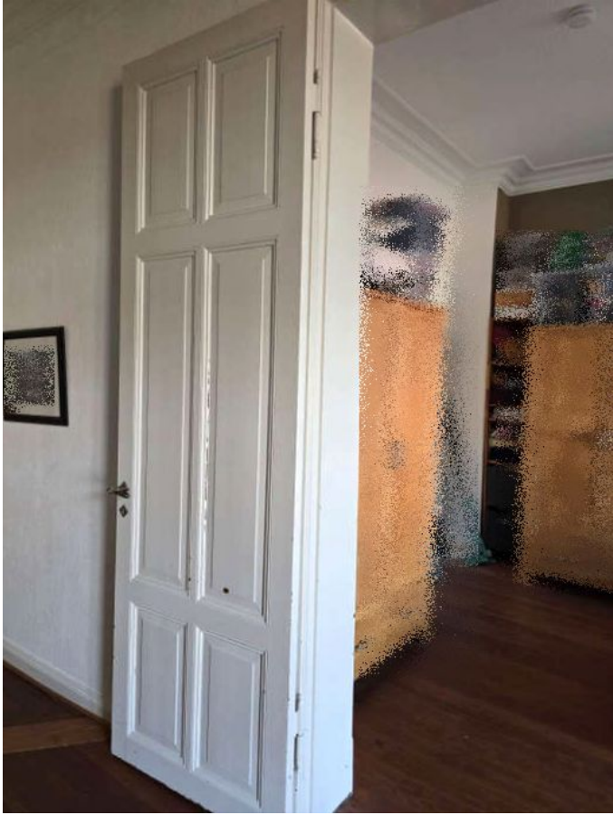
↑ Bild 11: Blick auf eine der beiden dreiflügeligen Verbindungstüren
