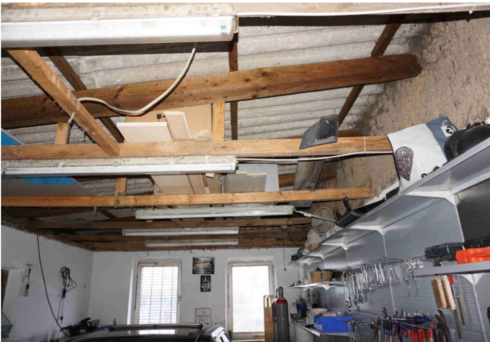
↑ Bild 22: Innenansicht der Garage
