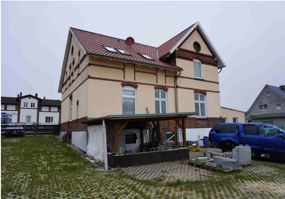
↑ Bild 5: Gebäuderückseite mit überdachtem Kellerzugang
