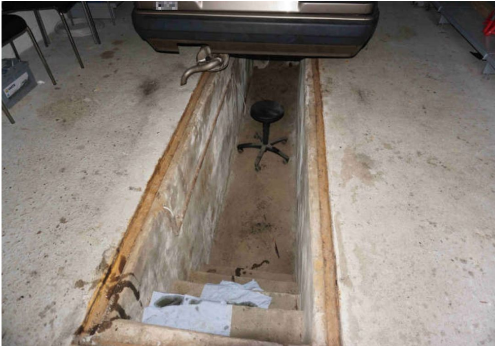
↑ Bild 23: Montagegrube in der Garage
