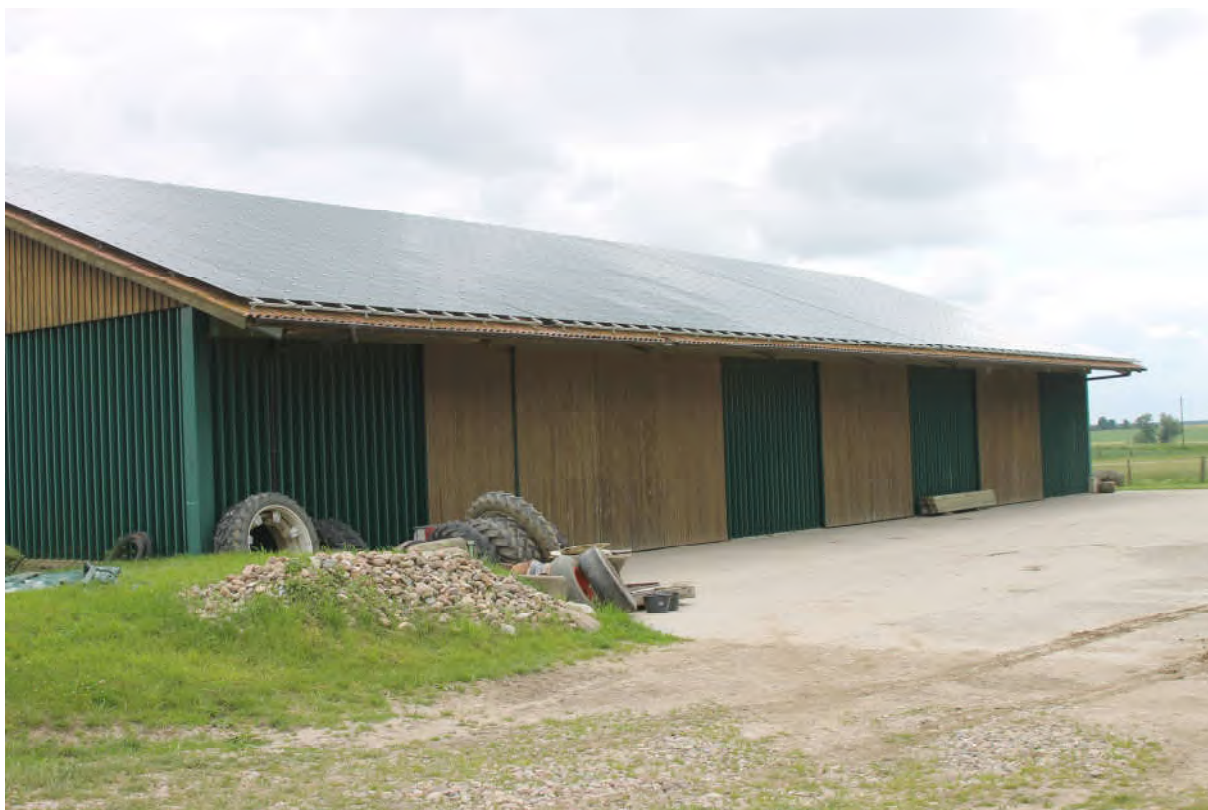
Bild 12: Sicht auf die Getreidelagerhalle auf den Flurstücken 169 und 170
