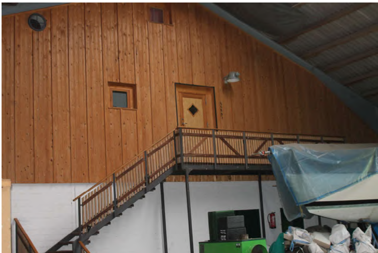
Bild 23: Sicht auf den Zugang zur Einliegerwohnung im Obergeschoss
