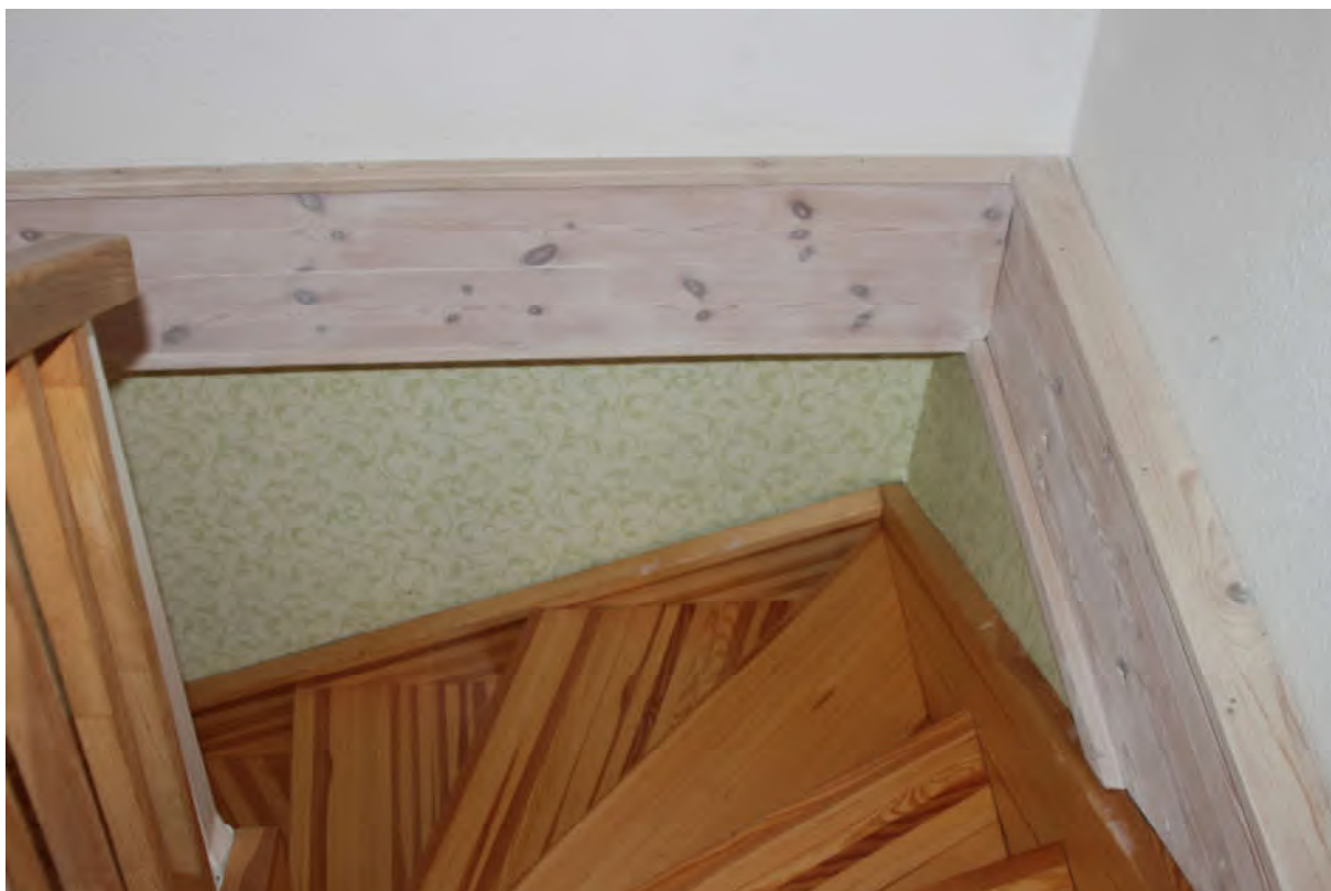
Bild 41: Blick auf die halbgewendelte Treppe zum Spitzboden
