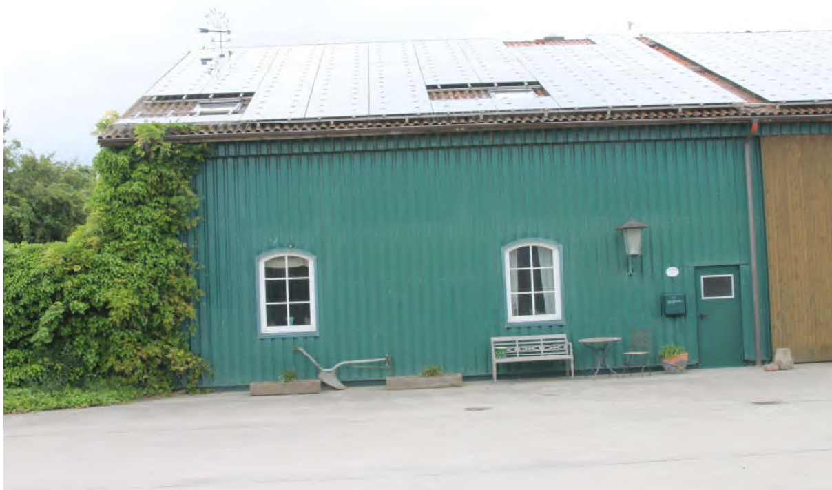
Bild 9: Ostansicht, Wohnbereich der Halle
