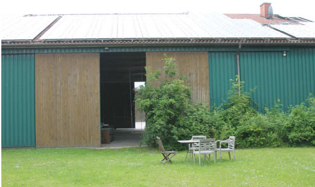
Bild 7: Westansicht der Halle
