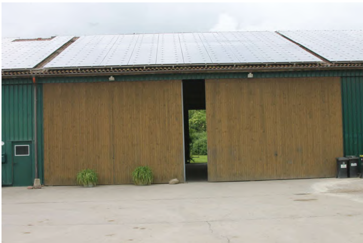
Bild 10: Ostansicht, Lager- und Unterstellbereich der Halle
