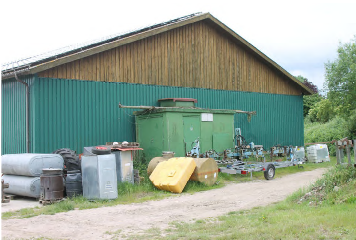
Bild 11: Nordgiebel der Unterstellhalle mit Wohnteil
