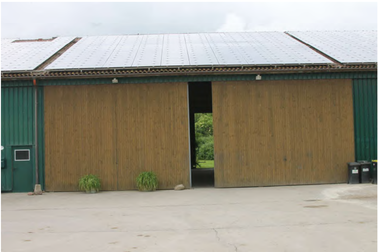
Bild 10: Ostansicht, Lager- und Unterstellbereich der Halle
