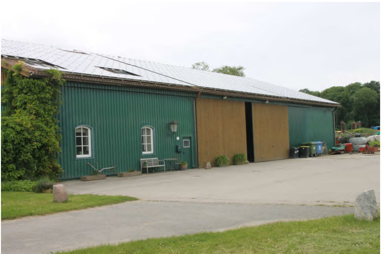
Bild 2: Sicht auf die Unterstellhalle mit Betriebsleiter- und Einliegerwohnung
