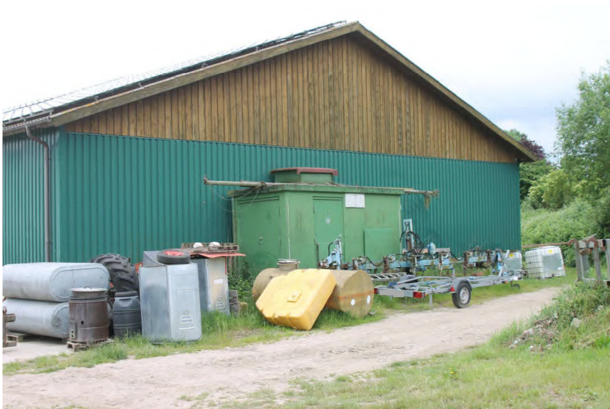
Bild 11: Nordgiebel der Unterstellhalle mit Wohnteil
