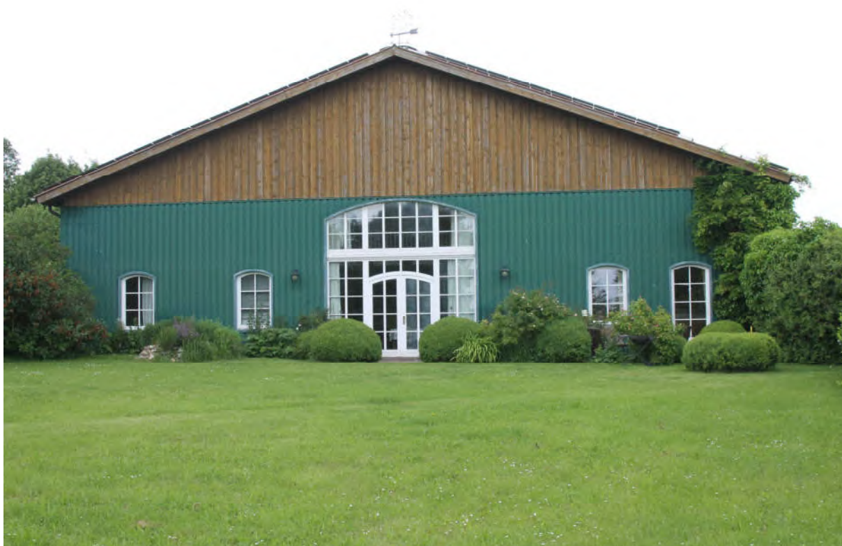
Bild 4: Südansicht der der Unterstellhalle mit Wohnteil
