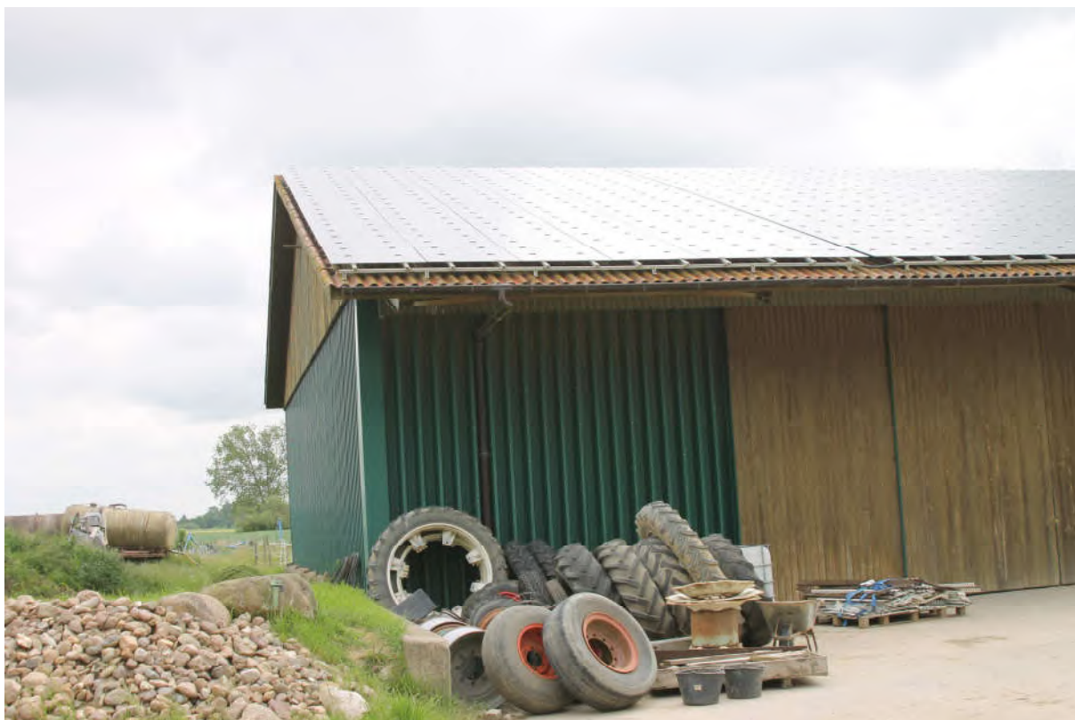
Bild 15: Detail der Getreidelagerhalle
