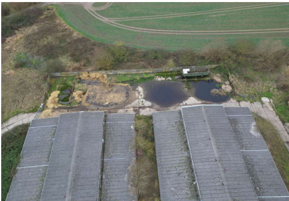
↑ Bild 14: Blick auf die Dunglege westlich des Gebäudes (Drohnenaufnahme)
