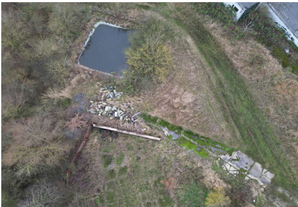
↑ Bild 18: Feuerlöschteich (Drohnenaufnahme)
