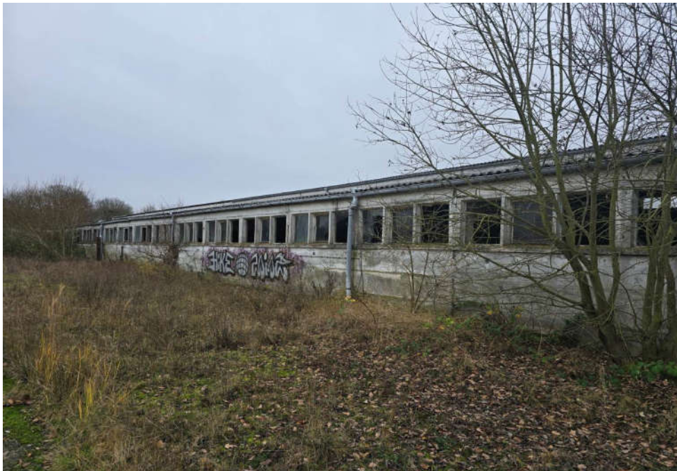
↑ Bild 3: Nordseite der ehemaligen Rindermastanlage
