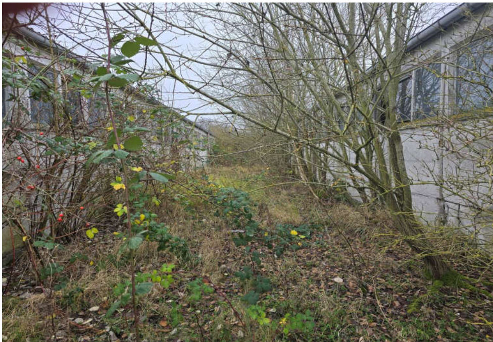
↑ Bild 6: Freifläche zwischen den beiden parallelen Stallgebäuden
