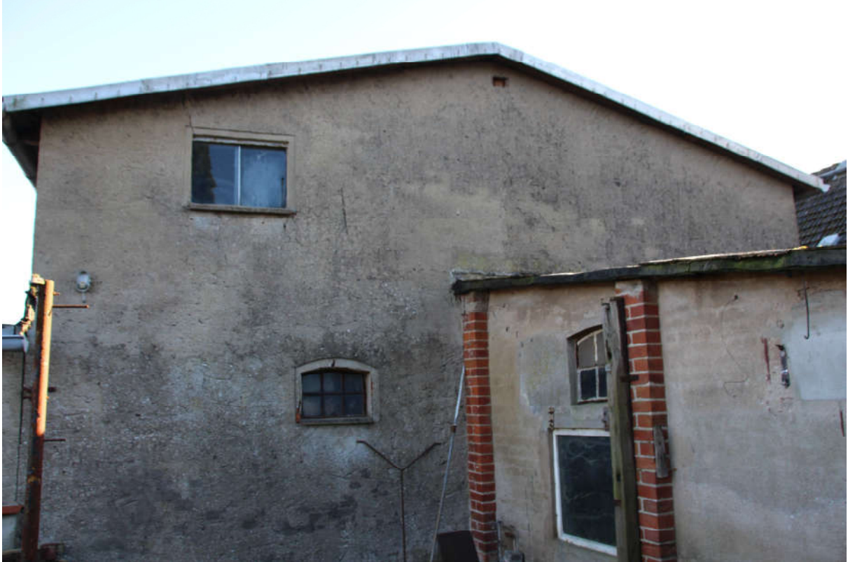
Bild 13: Rückfront des Stallgebäudes
