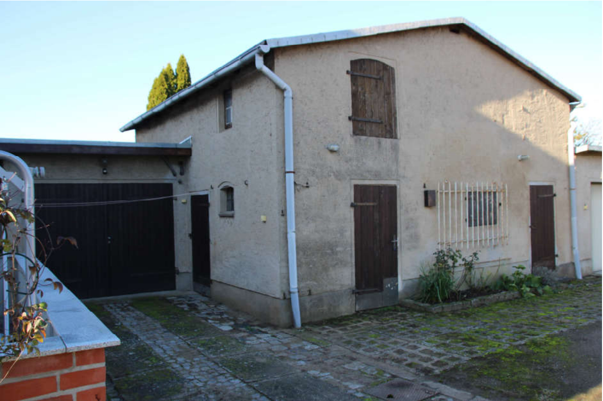
Bild 8: Blick auf das ehemalige Stallgebäude
