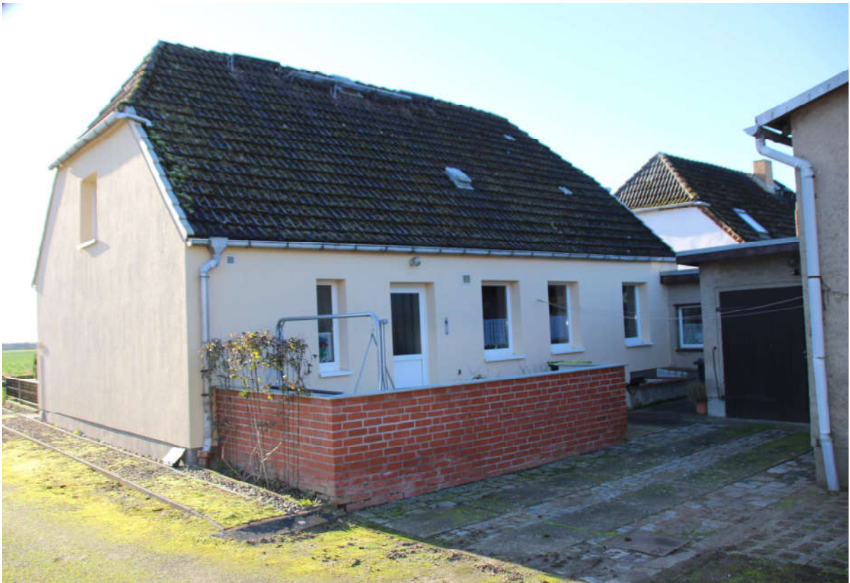
Bild 4: Rückfront des Einfamilienhauses
