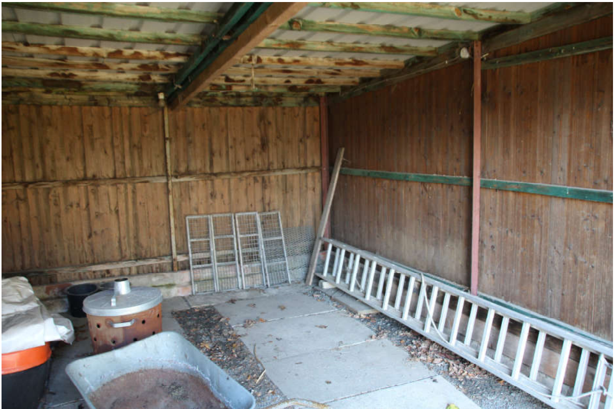
Bild 14: Carport an der Garage
