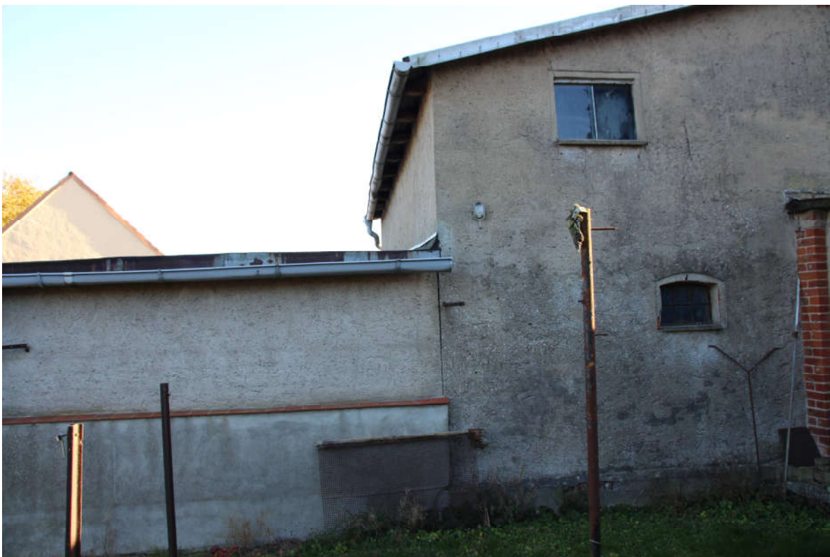
Bild 11: Rückfront des ehemaligen Stallgebäudes und der angebauten Garage
