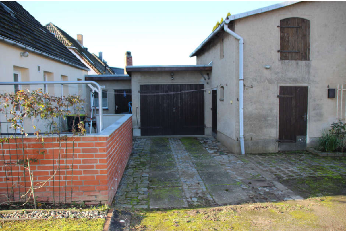
Bild 5: Sicht auf die baulichen Nebenanlagen hinter dem Einfamilienhaus (Waschküche, Garage mit Heizungsraum und ehemaliger Stall)
