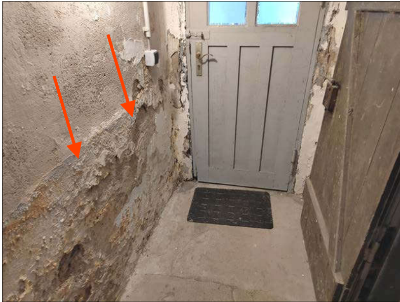
Feuchtigkeitsschäden
