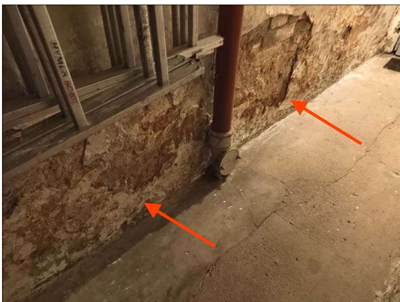
Feuchtigkeitsschäden
