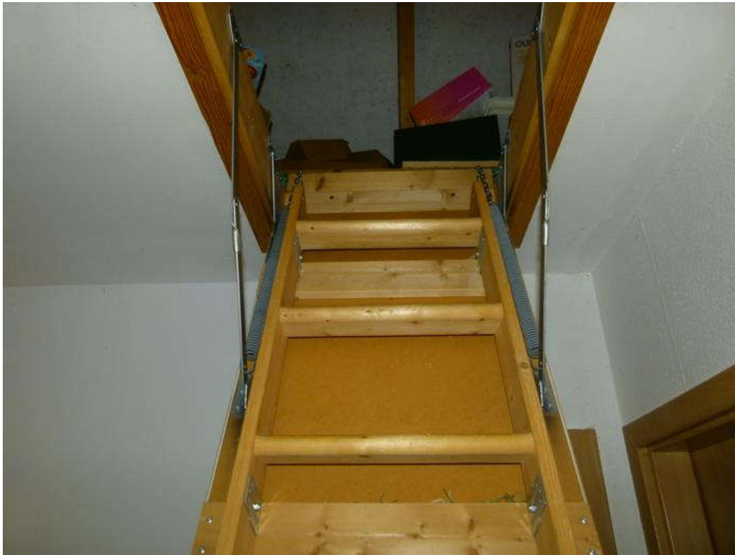
Bild 17 - Auszugstreppe zum Spitzboden
