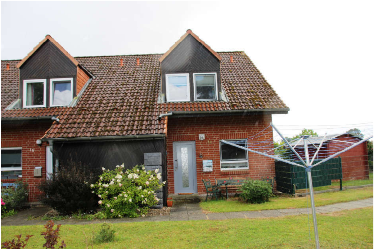
Bild 1 und Bild 2: Blick auf das Reihenendhaus, Nordansicht
