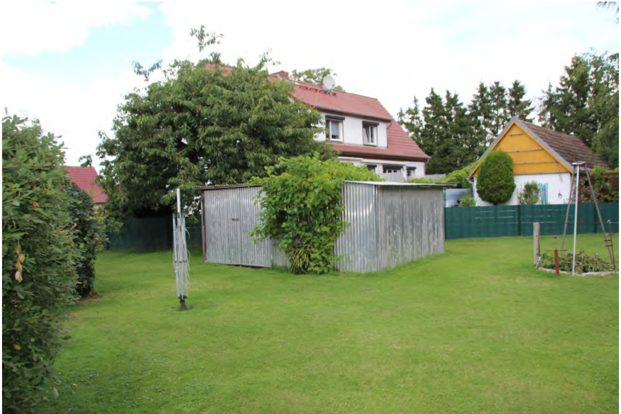
Bild 9: Abstellschuppen in Leichtbauweise
