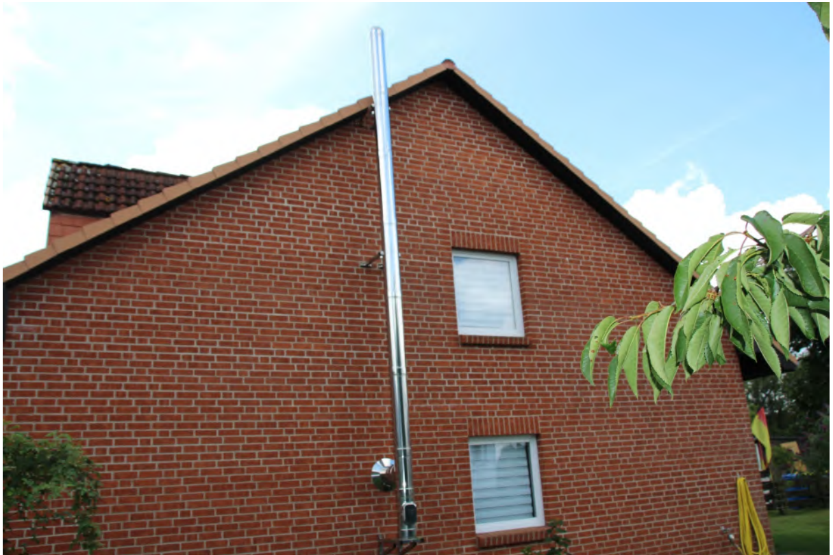
Bild 3 und Bild 4: Sicht auf den Giebel, Ostansicht
