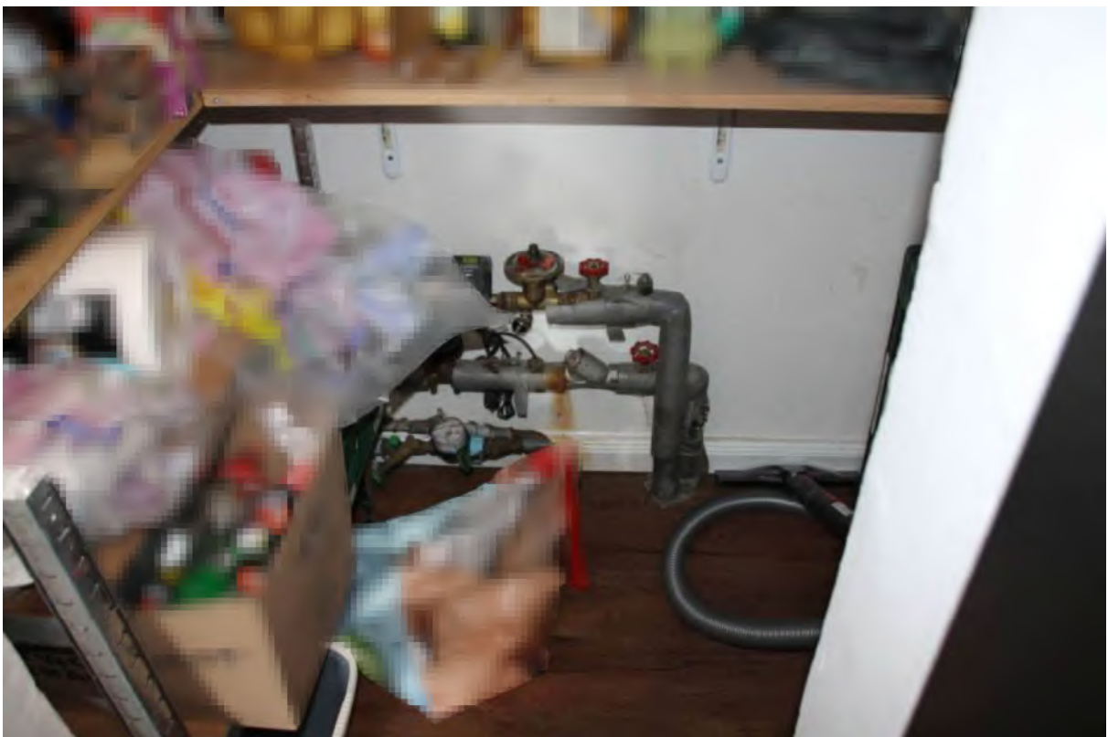
Bild 20: Abstellraum unter der Treppe
