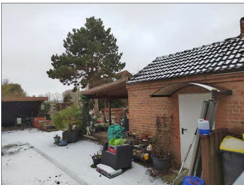
Ansicht Nebengebäude mit Anbau
