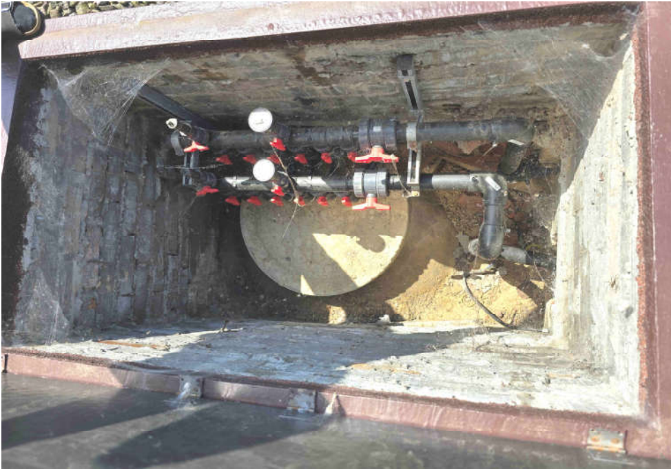
↑ Bild 21: Einspeisung der Sohle für die Erdwärmepumpe
