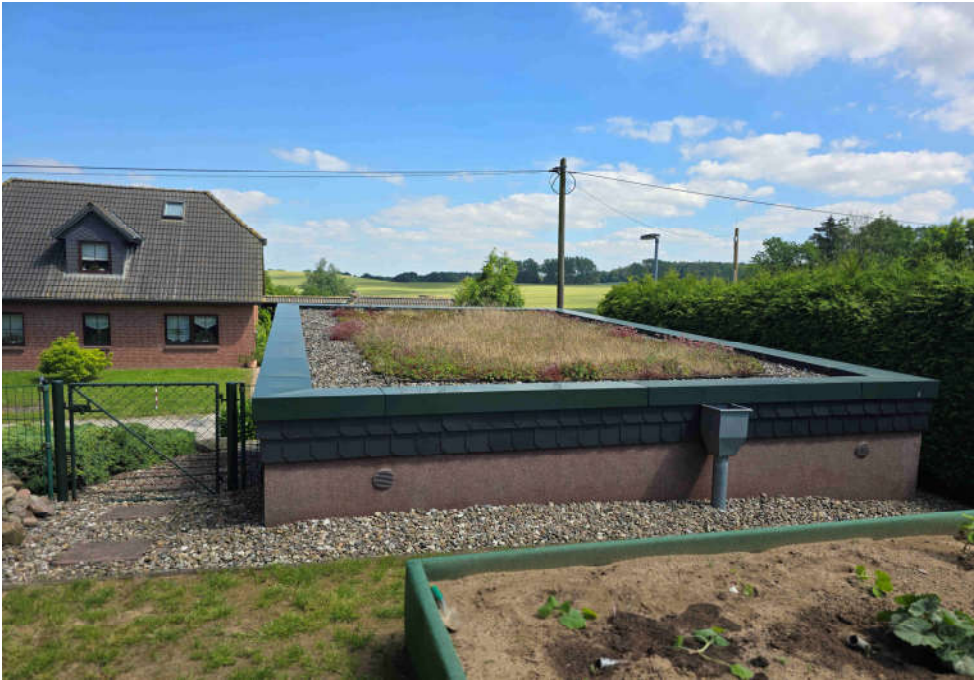
↑ Bild 5: Gründach der Garage
