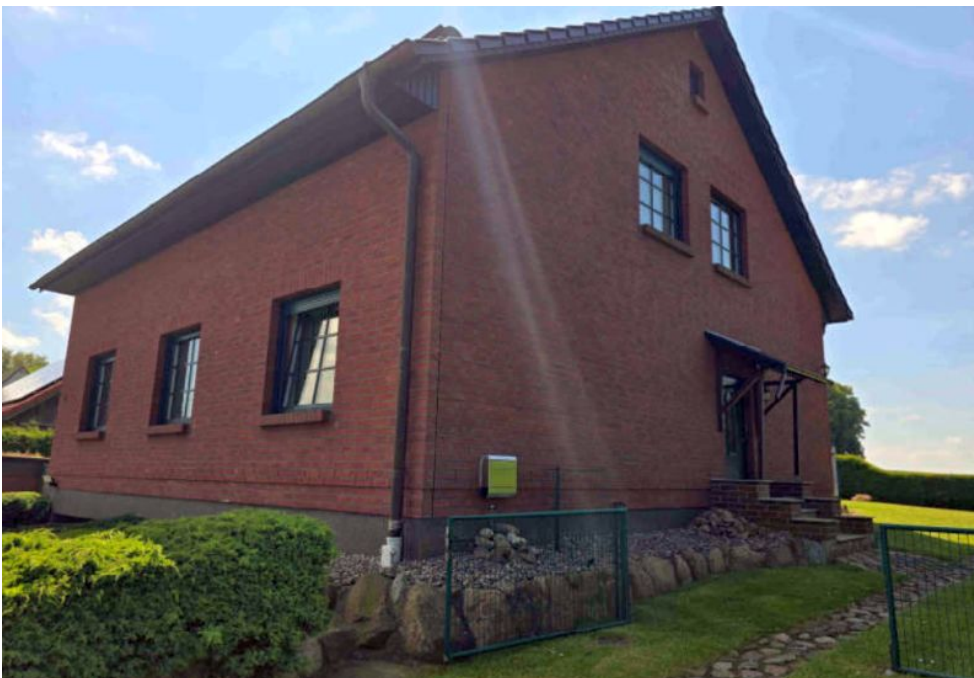
↑ Bild 2: Nordgiebel des Einfamilienwohnhauses mit Einliegerwohnung
