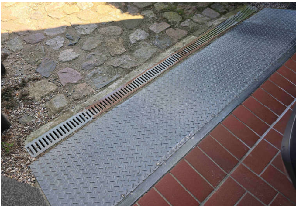
↑ Bild 20: Schwelle der Garage im Kellergeschoss
