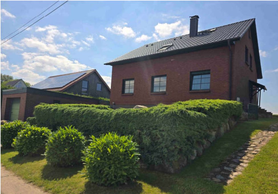
↑ Bild 1: Blick aus Richtung Nordosten auf das Bewertungsgrundstück 1
