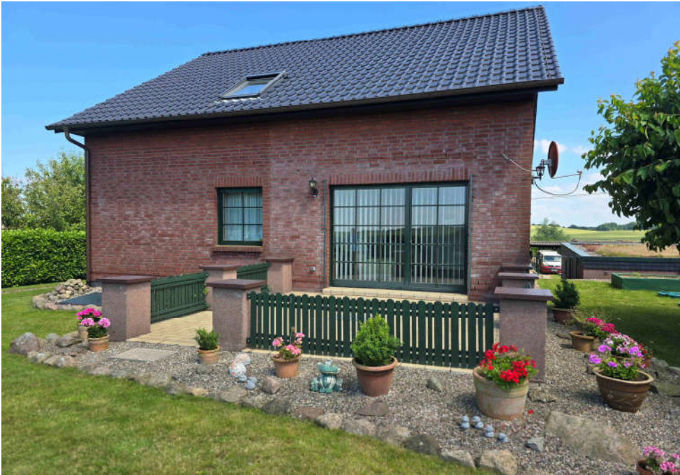
↑ Bild 3: Westseite mit Terrasse
