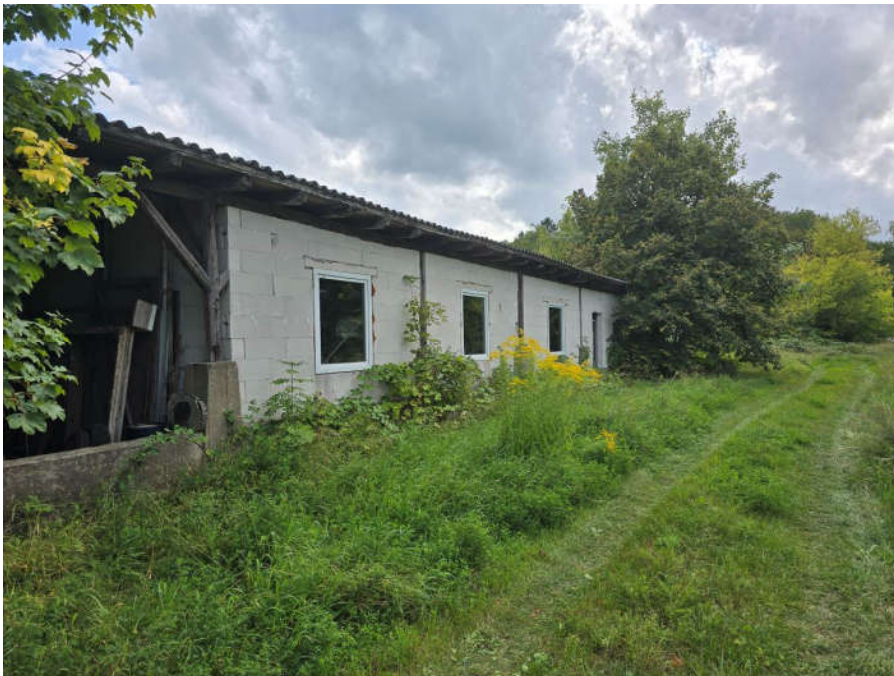
↑ Bild 8: massiv ausgebauter Bereich des Schleppdaches
