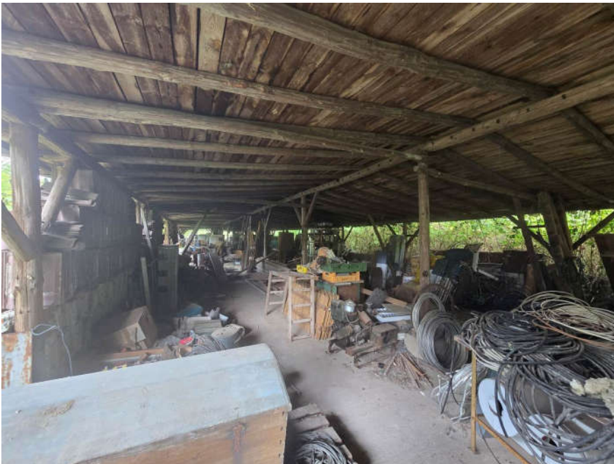
↑ Bild 14: unter dem östlichen Schleppdach gelagerte Materialien
