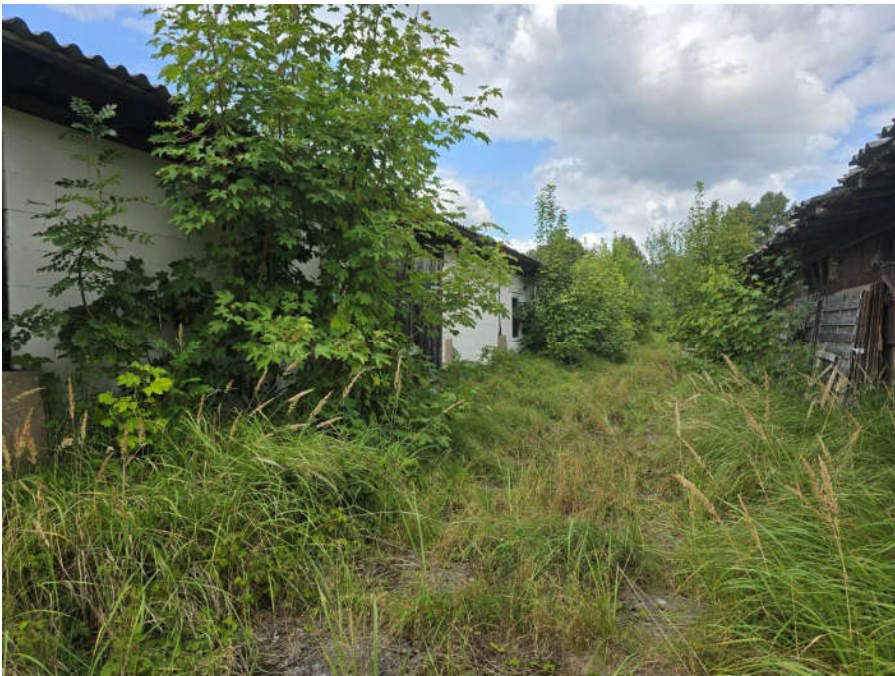
↑ Bild 12: Freifläche zwischen den Schleppe dächern
