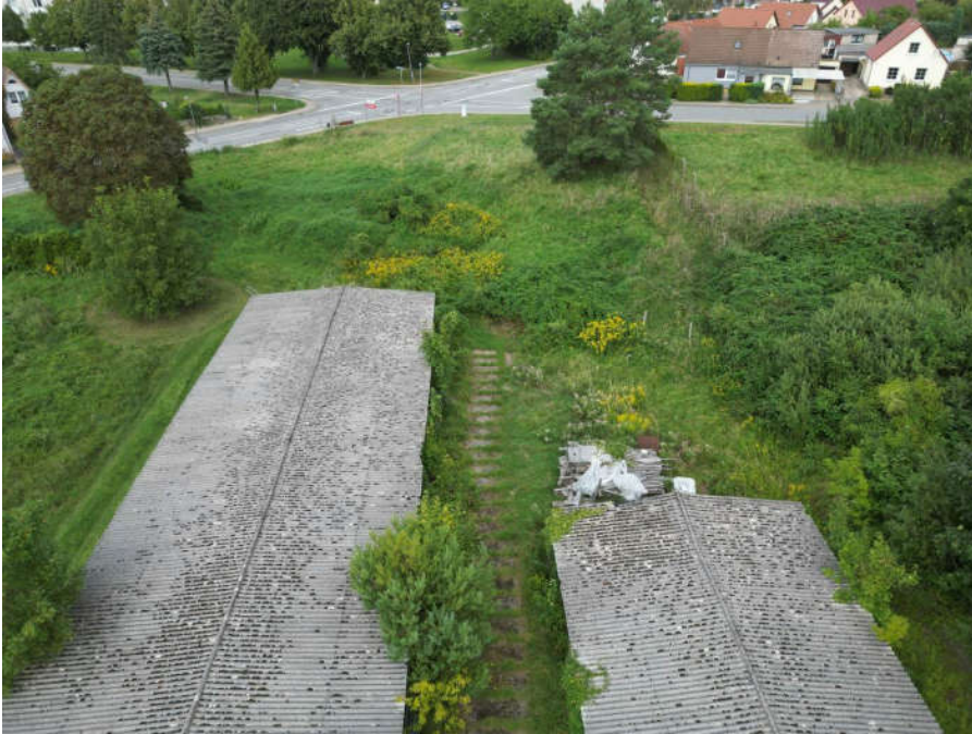
↑ Bild 5: Blick auf die Böschung
