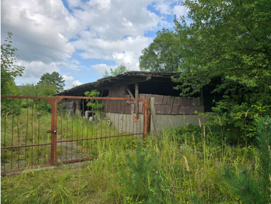
↑ Bild 11: Blick auf das östliche Schleppe Dach
