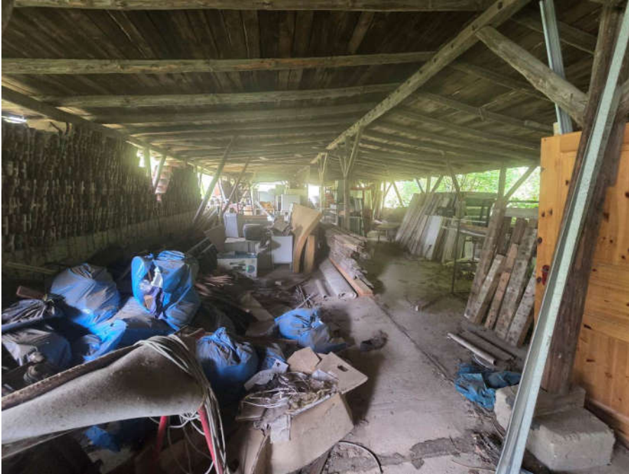
↑ Bild 15: unter dem östlichen Schleppdach gelagerte Materialien
