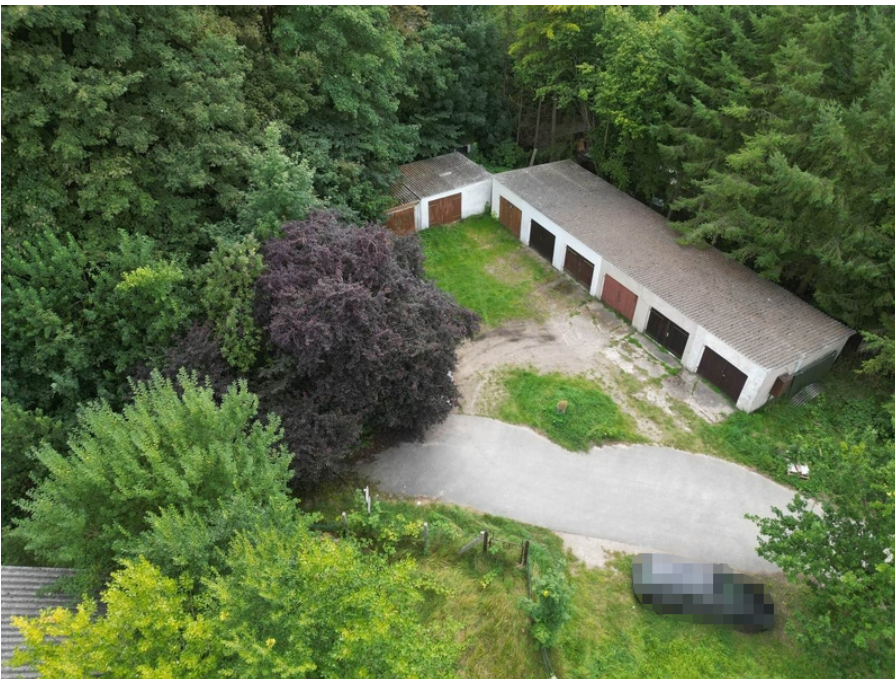
↑ Bild 18: Blick auf die Garagen
