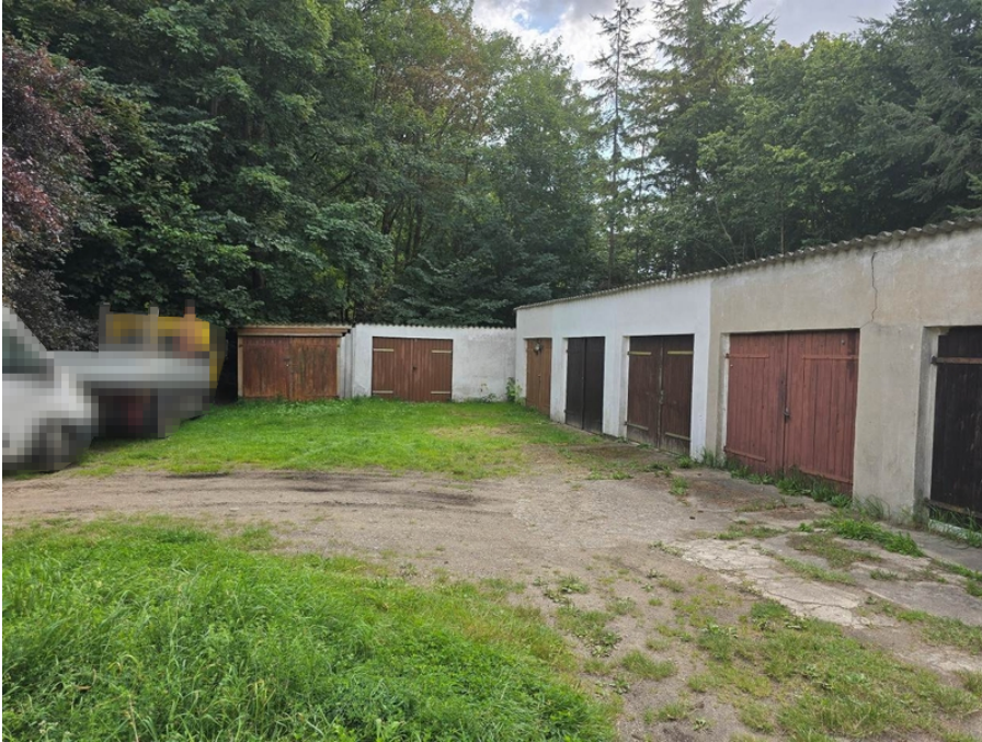
↑ Bild 19: Blick auf die Garagen
