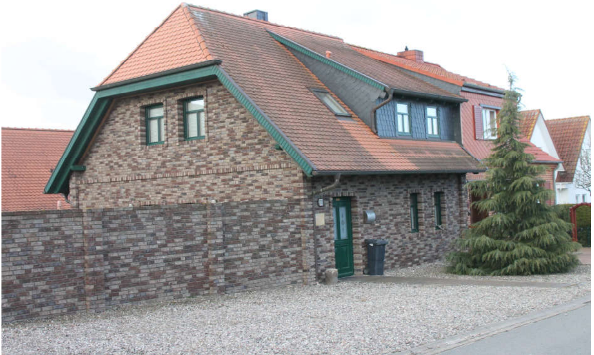
Bild 1 und Bild 2: Blick von der Straße auf die Doppelhaushälfte in der Wichmannsdorfer Straße 5
