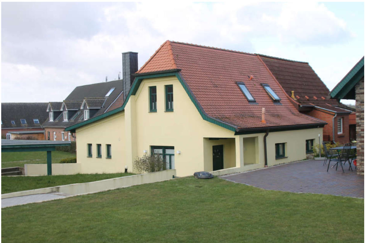
Bild 10: Sicht auf die Doppelhaushälfte in der Wichmannsdorfer Straße 5a
