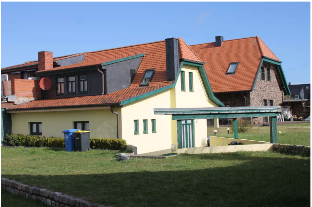
Bild 16: Sicht auf die beiden Doppelhaushälften auf dem Grundstück
