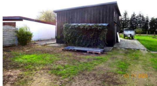
Lager- und Abstellgebäude, Nordostansicht
