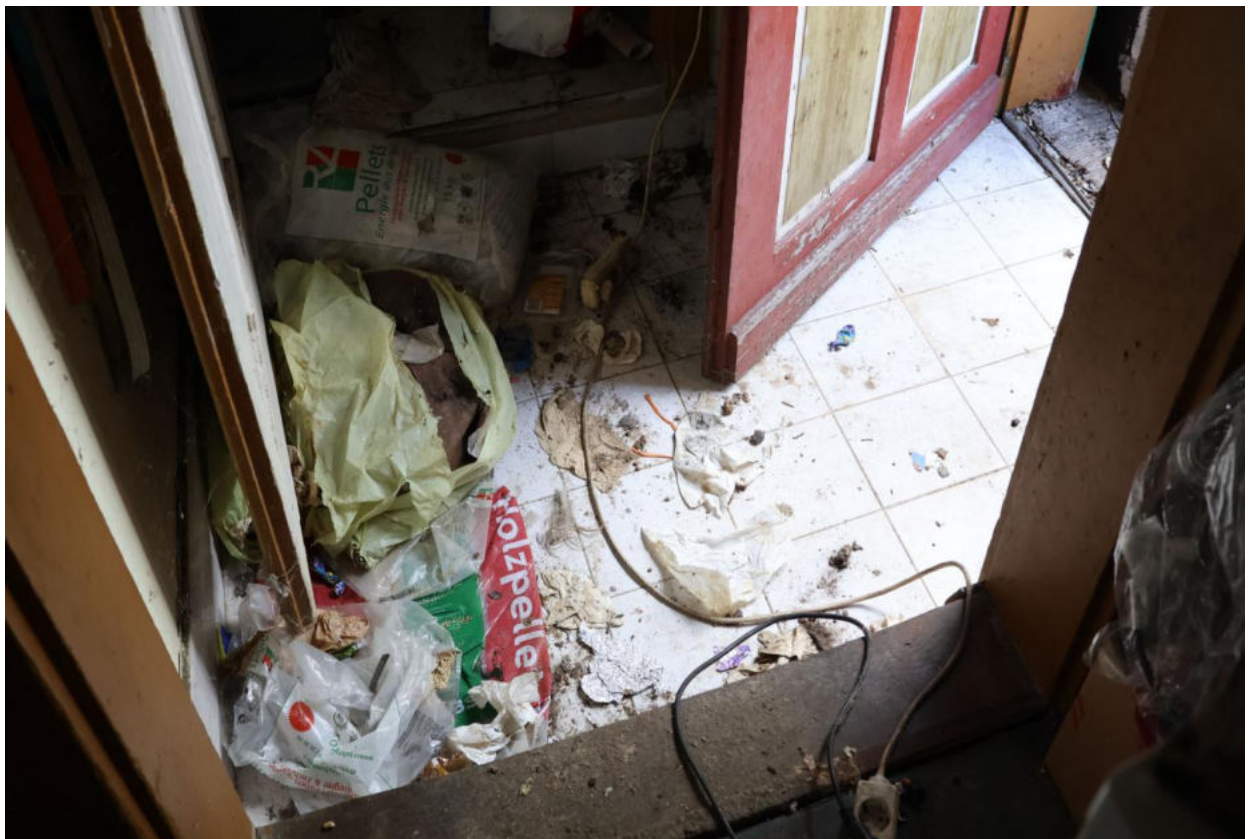
Bild 10 Hauseingangstüre mit EG-Vorraum
