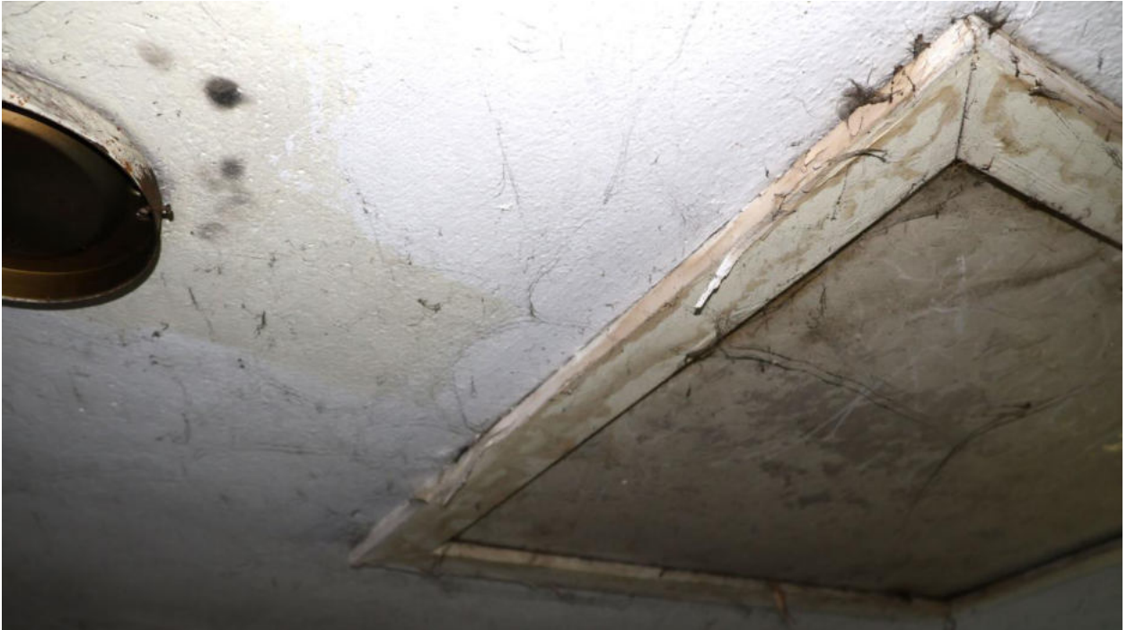
Bild 27 DG Einstiegs Luke in den Spitzboden
