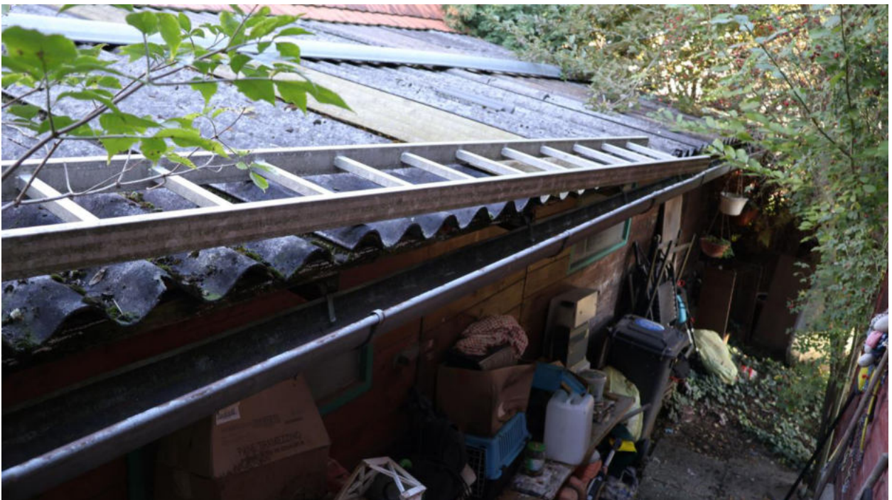
Bild 28 Nebengebäude Ostseite mit Anbauteil
