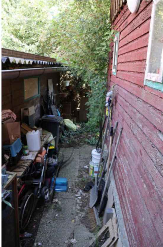
Bild 29 Nebengebäude mit Zugang von der Ostseite
