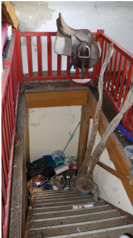
Bild 20 Stiegenaufgang ins DG mit Holzterppe
