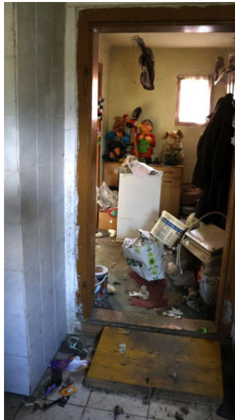
Bild 16 EG Vorraum mit Zugang zur Küche
