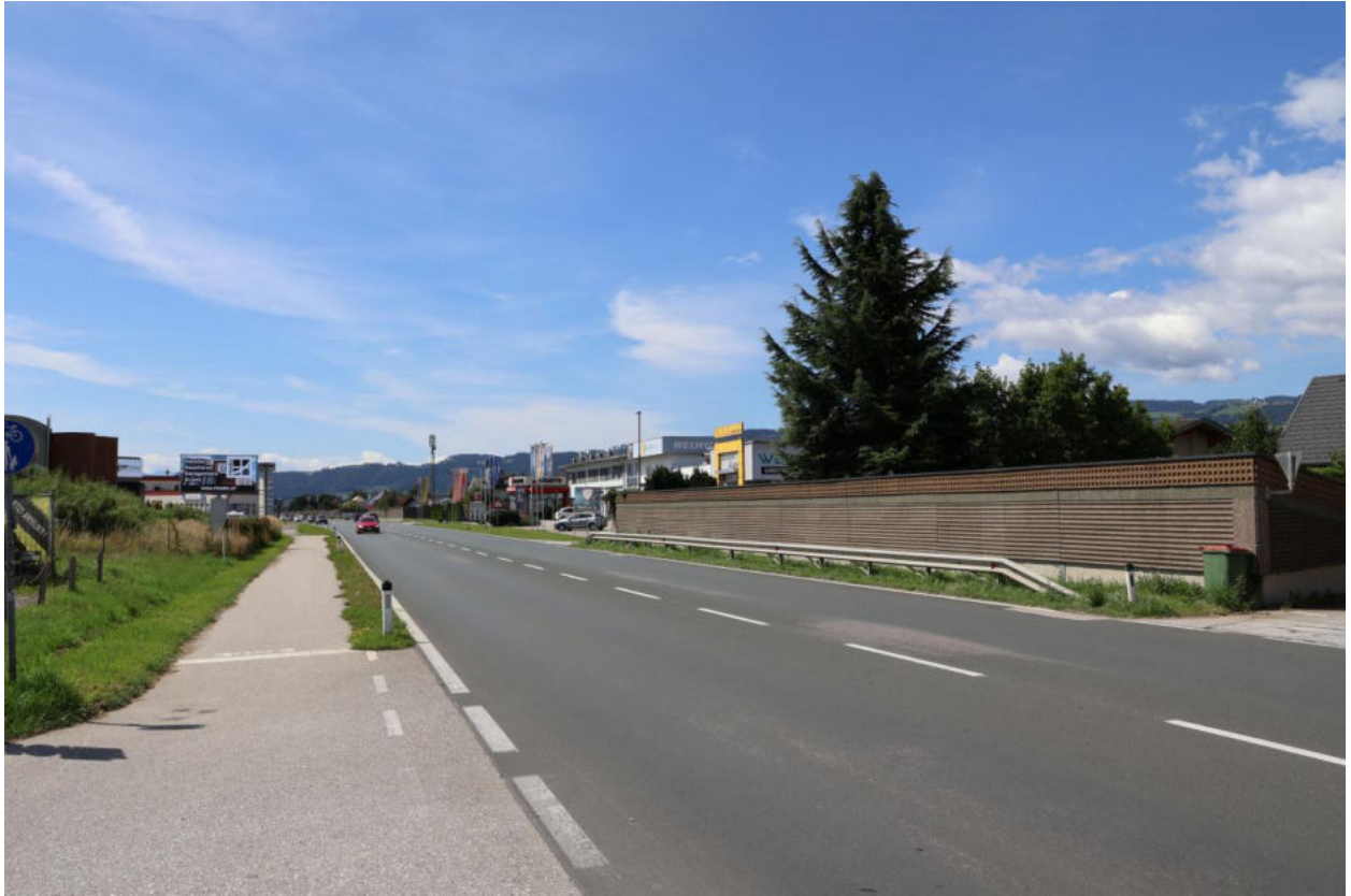
Bild 35 Klagenfurter Straße Blickrichtung Süden
