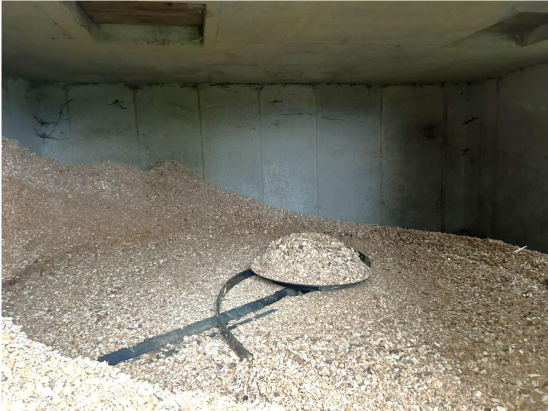
Bild 9: Hackgut-Raumaustragung
