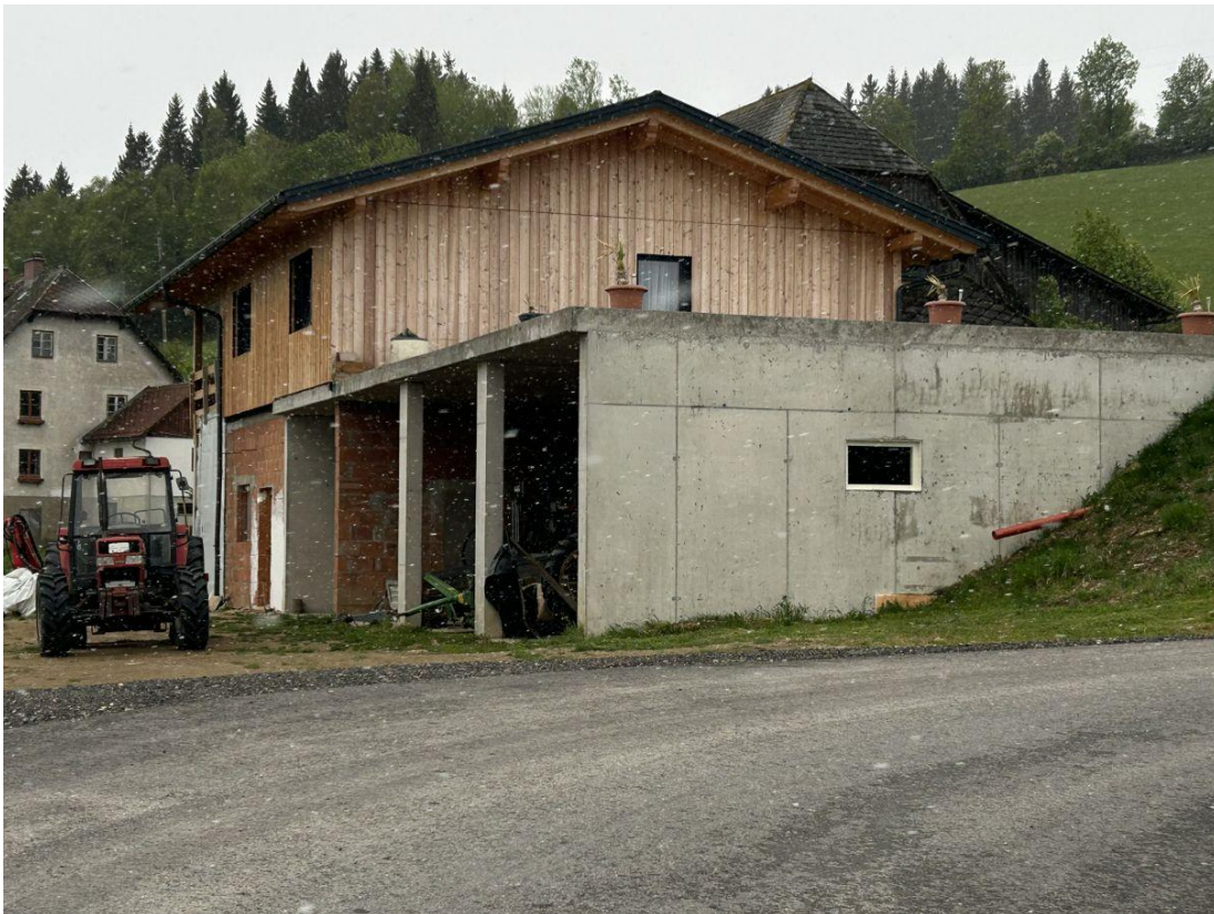
Bild 16: neuer Geräteschuppen mit Auszugswohnhaus
