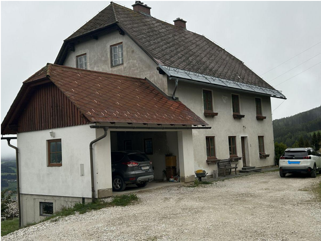
Bild 1: altes Wohnhaus und Zubau Nordansicht
