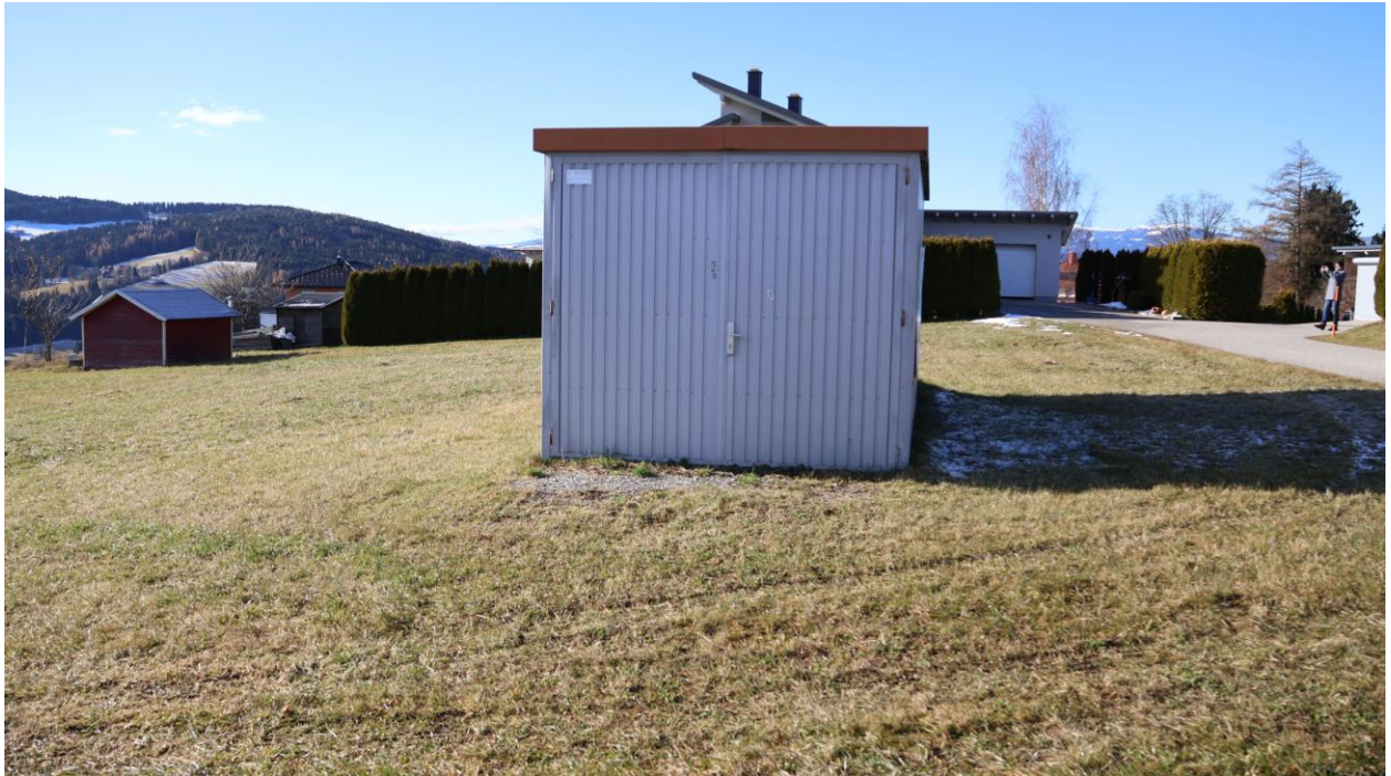
Containernansicht Ostseite mit dem doppelflügeligen Blechtür, welches bei der Besichtigung versperrt war!
