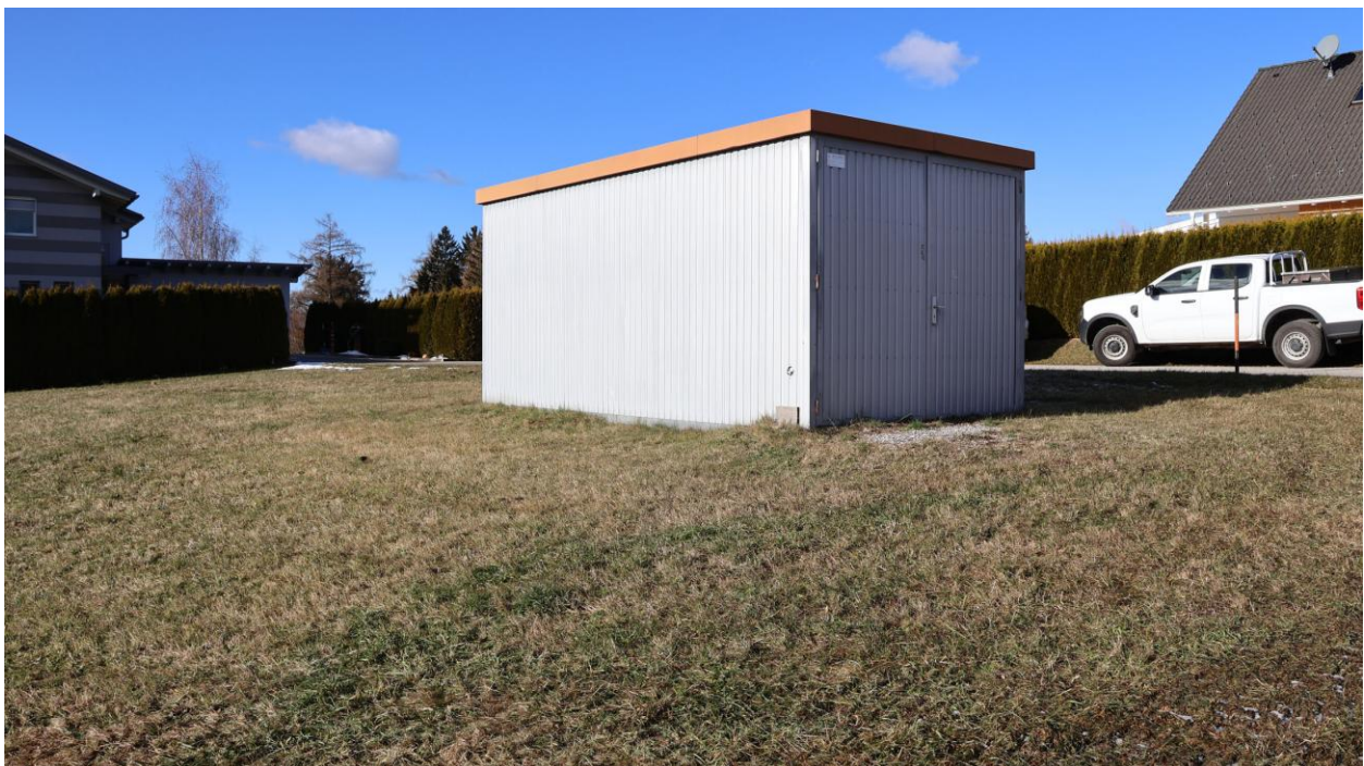
Bild 4 Metallcontainer – Ansicht von der Südostseite
