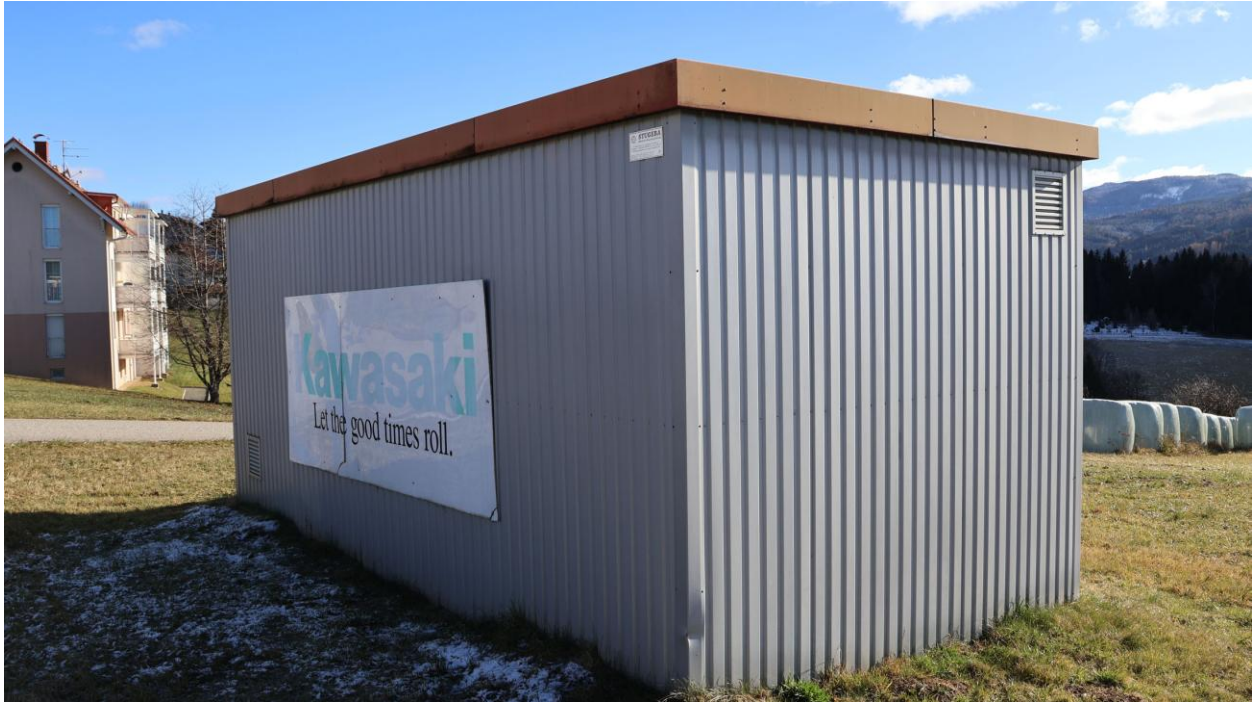
Bild 5 Metallcontainer – Ansicht von der Nordwestseite
