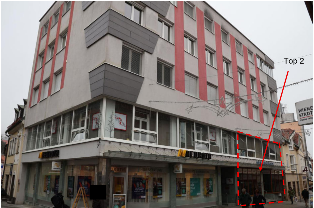
Bild 1 Gebäudeansicht von der Nordwestecke
