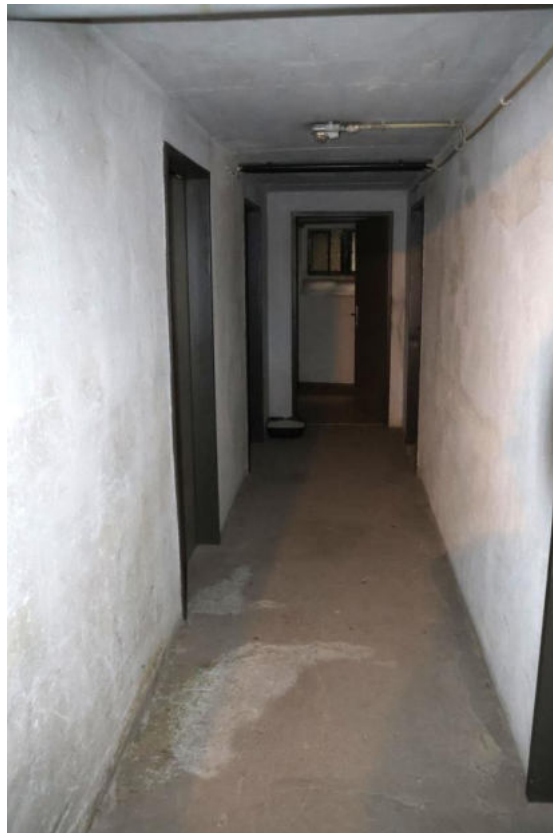
Bild 38 KG Nordtrakt der WE-Anlage
