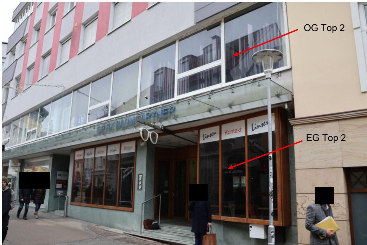
Bild 3 Ansicht Geschäftslokal Top 2 mit Zugang von der Wiener Straße
