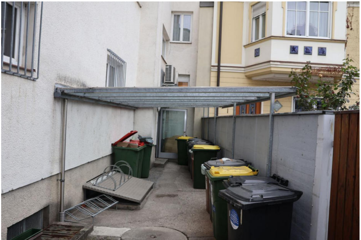
Bild 36 Überdachter Müllplatz im Hofbereich zum Stiegenhaus
