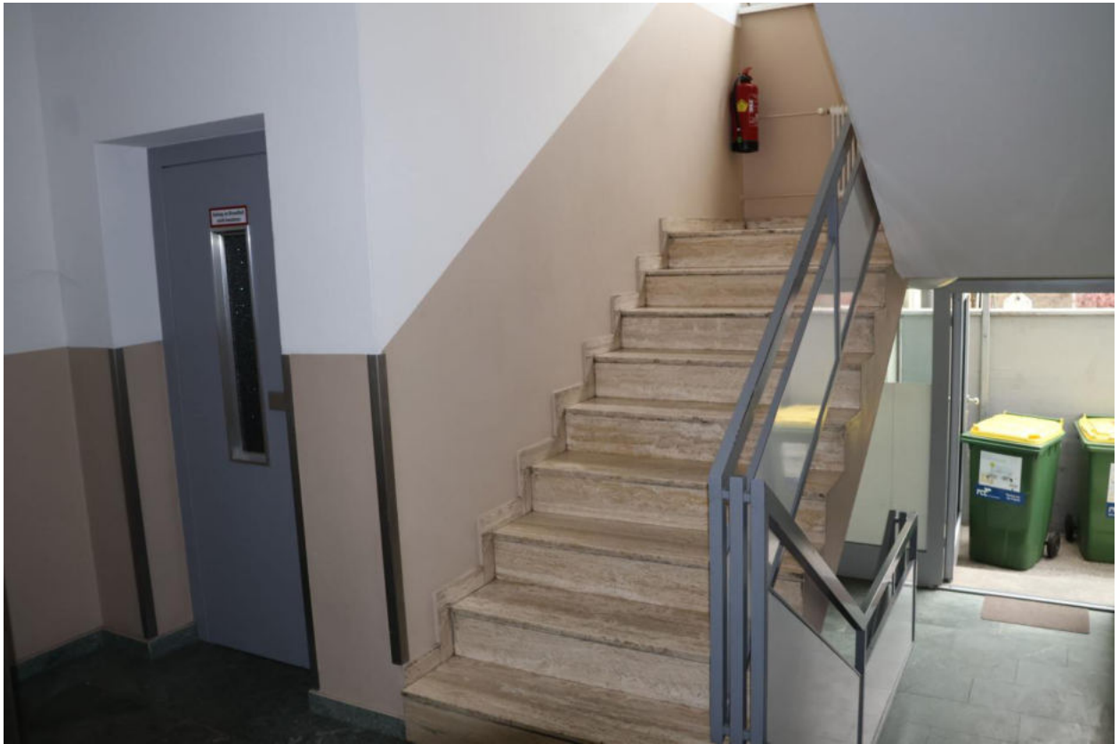
Bild 21 EG-Stiegenhaus mit Aufzug und Abgang zum Innenhof
