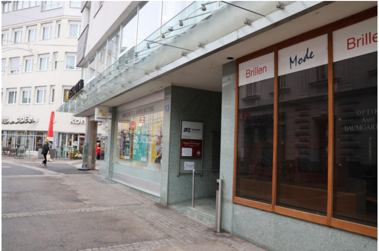
Bild 19 Wiener Straße Westseite mit Hauptzugang zur WE-Anlage
