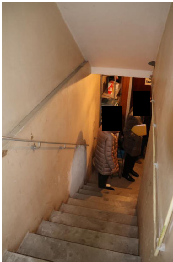
Bild 26 Stiegenabgang in den vermieteten Keller der Top 2
