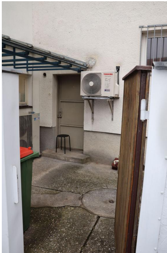
Separater Kellerzugang Top 2 von außen
