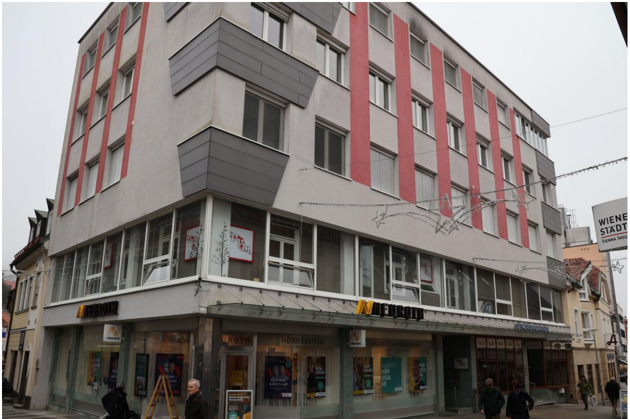
Gebäudeansicht von der Nordwestecke
