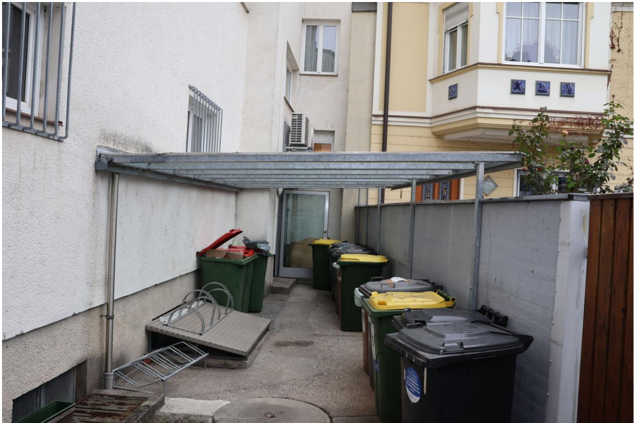
Abgegrenzter Innenhof mit Zugang zum Stiegenhaus
