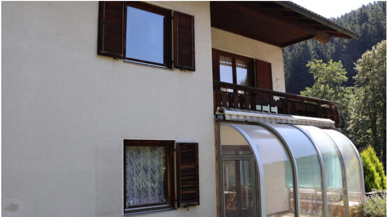
Bild 7 Westfassade mit Wintergarten und Balkon im OG
