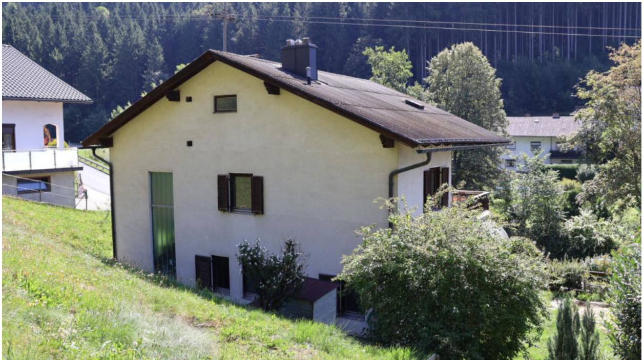
Bild 4 Gebäudeansicht von der Nordwestseite
