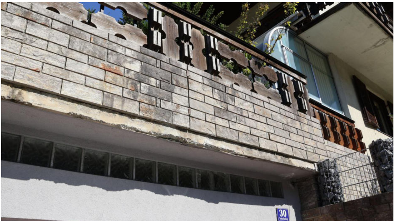
Bild 70 Flachdachausbildung Garagenanbau mit südseitiger Attikawand
