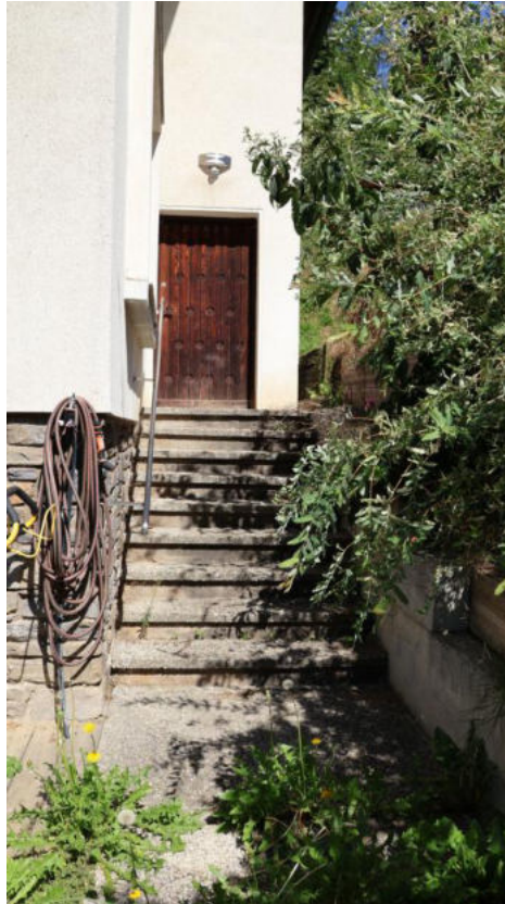
Bild 9 Hauszugang über Freitreppe von der Südostseite
