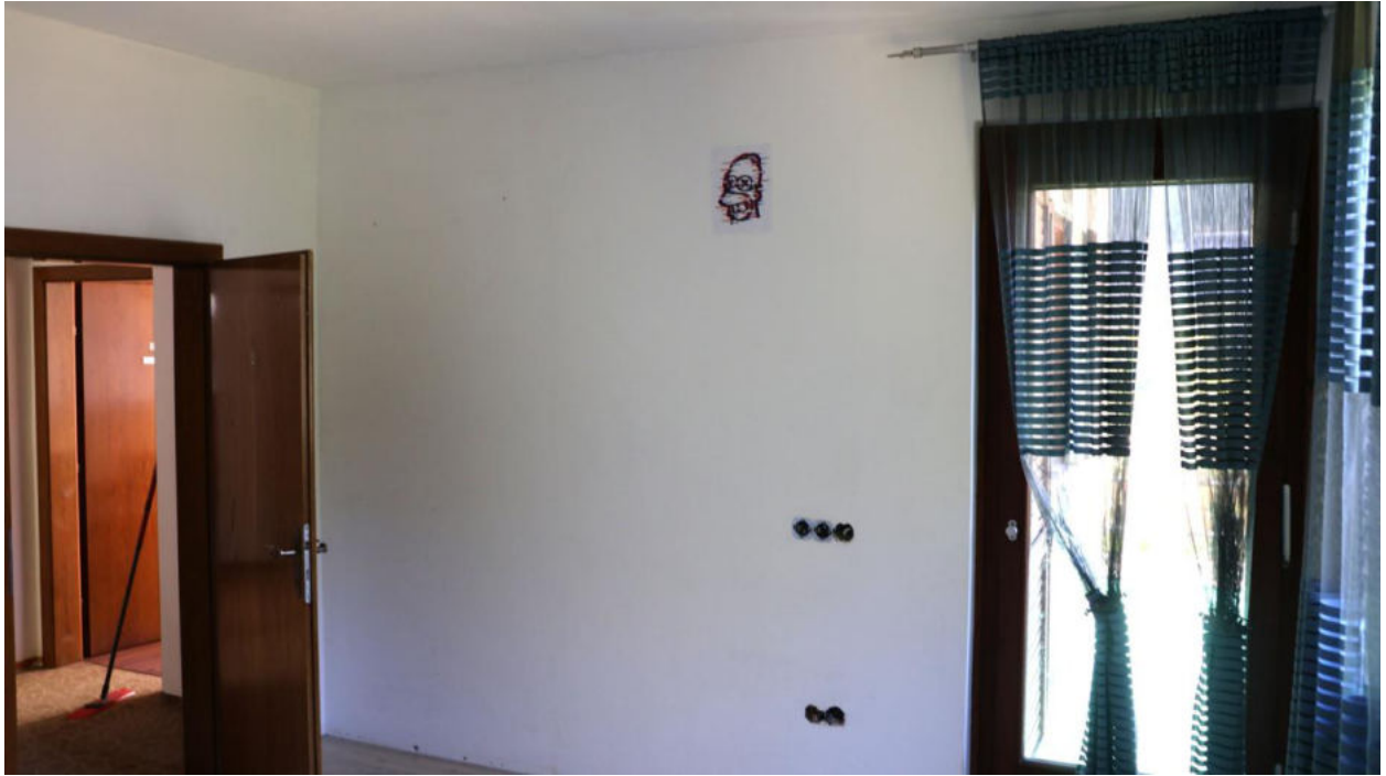
Bild 37 OG Zimmer West
