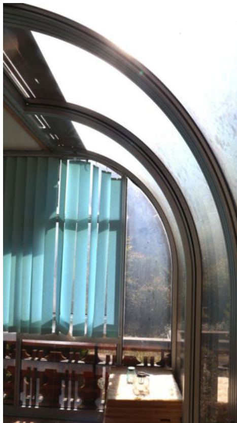
Bild 18 EG Wintergarten mit gekrümmten Plexiglas-Profilelementen
