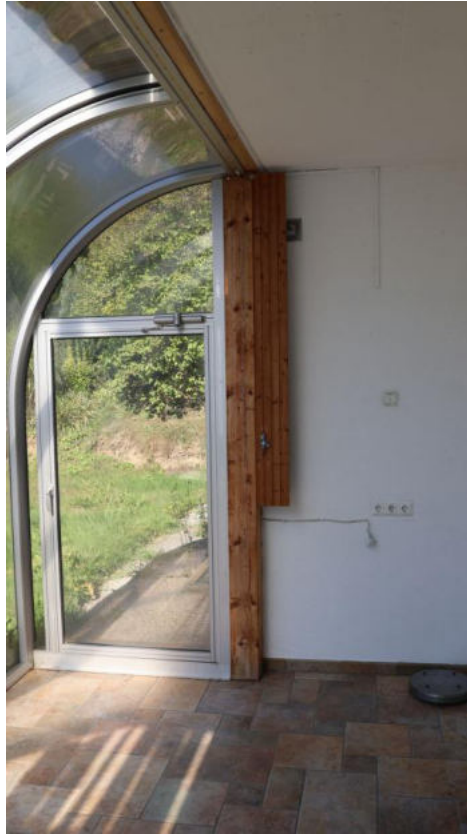
Bild 17 EG Wintergarten mit Terrassentüre an der Nordseite
