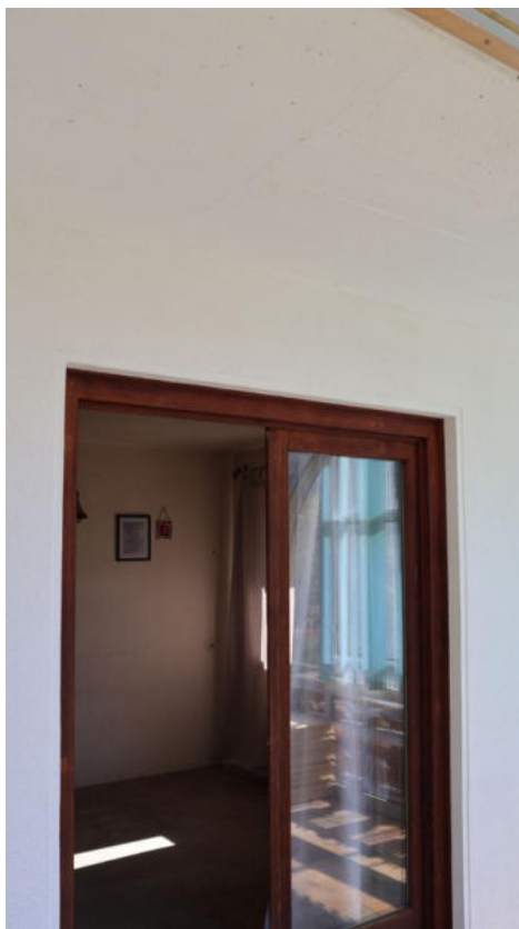
Bild 19 Wintergartenzugang von außen zur Küche
