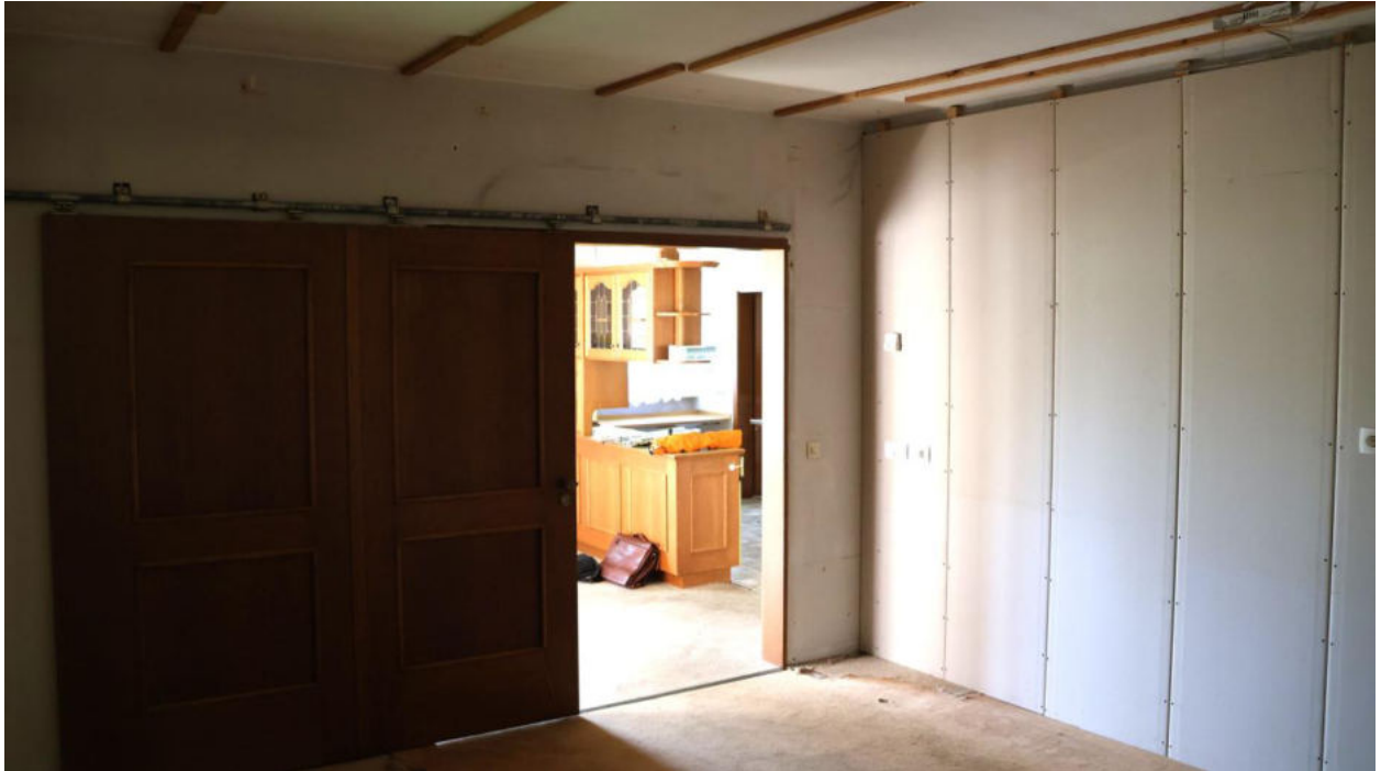
Bild 13 Gipsständerwand mit Schiebetüre vom Wohnzimmer zur Küche
