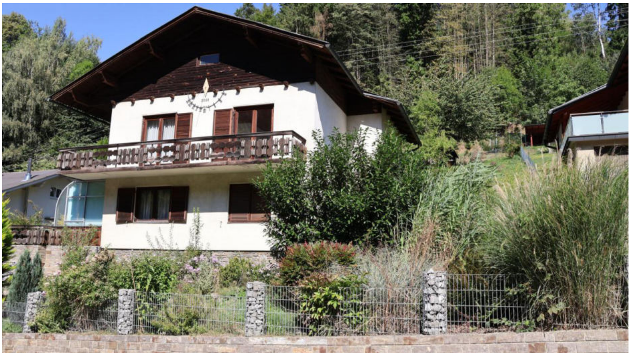
Bild 2 Gebäudeansicht von der Südostseite
