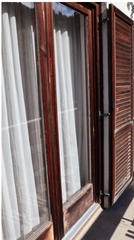
Bild 33 Balkonfenstertüren Südseite mit Holzbalkon
