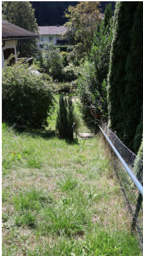
Bild 62 Einfriedung entlang der Westseite mit Handlauf
