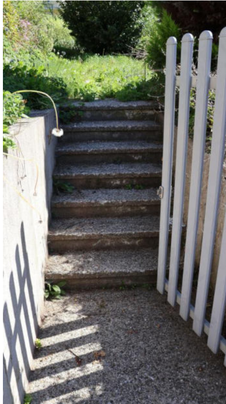
Bild 63 Zugangsstiege mit Gehrte vom Parkplatz
