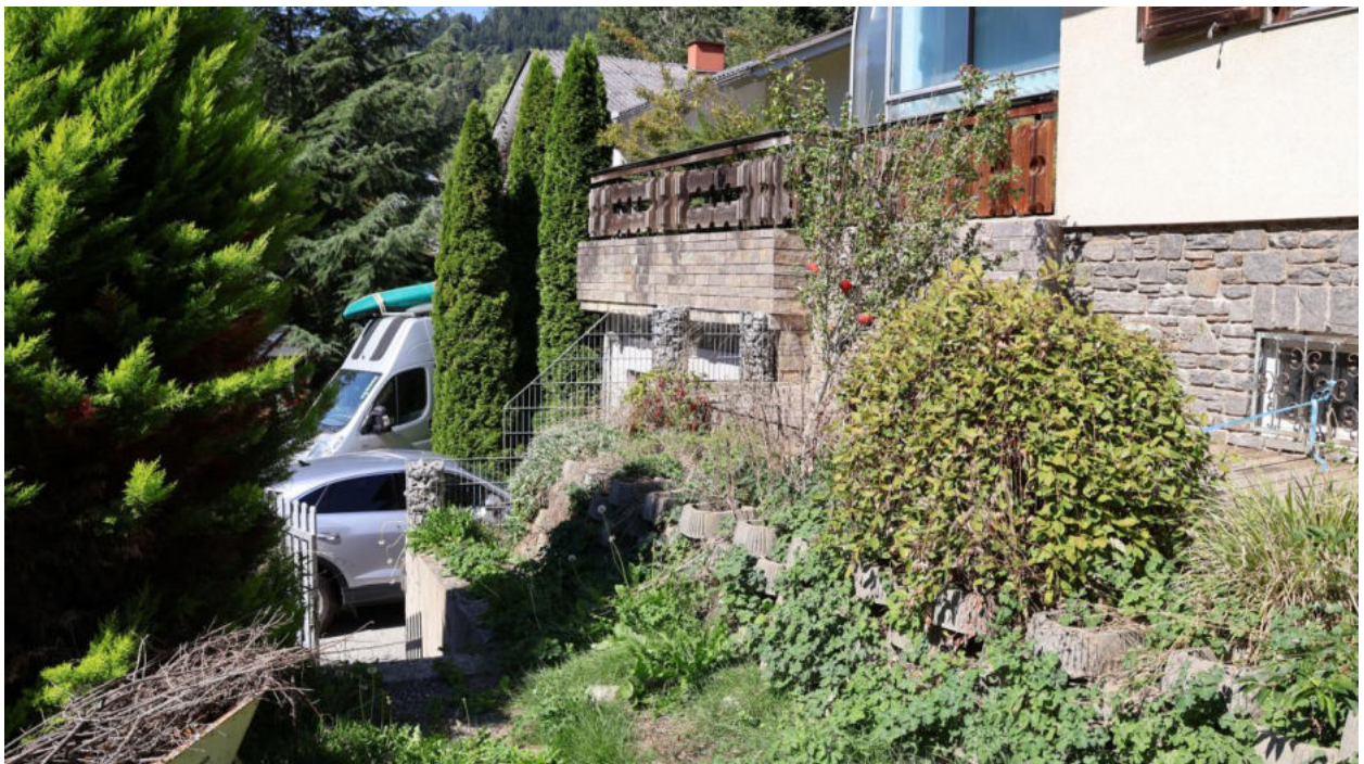
Bild 64 Böschungsbefestigung beim Hauszugang an der Südwestseite
