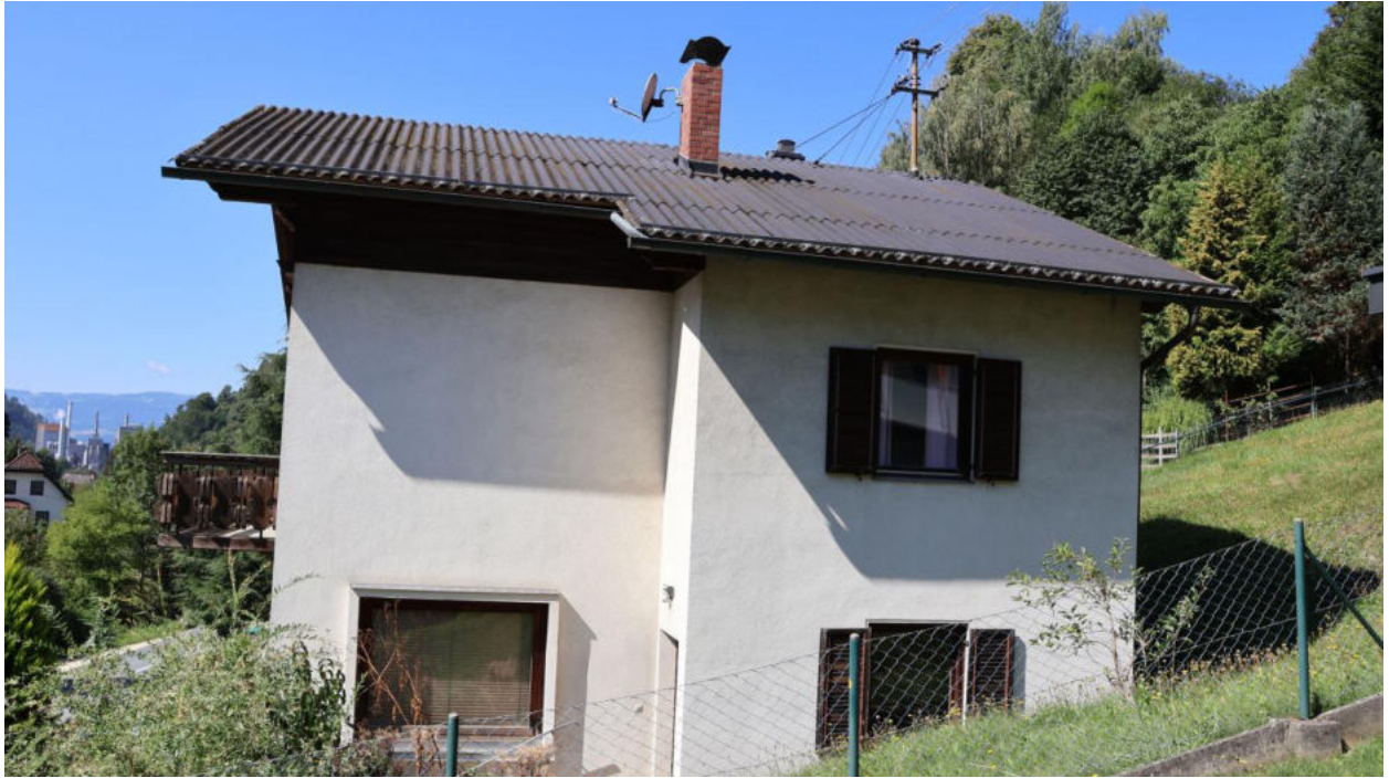
Bild 3 Gebäudeansicht von der Ostseite
