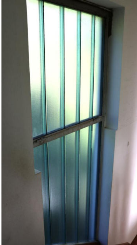
Bild 25 Stiegenhausfenster mit Stegverglasung und Stahlrahmenfenster
