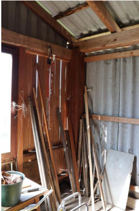
Wandkonstruktion Südwestecke mit kombinierter Bretter- und Trapezblechverkleidung
