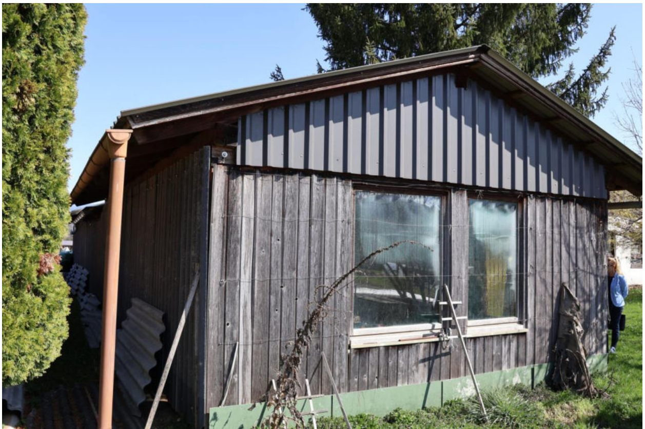
Gebäudeansicht von der Südwestseite
