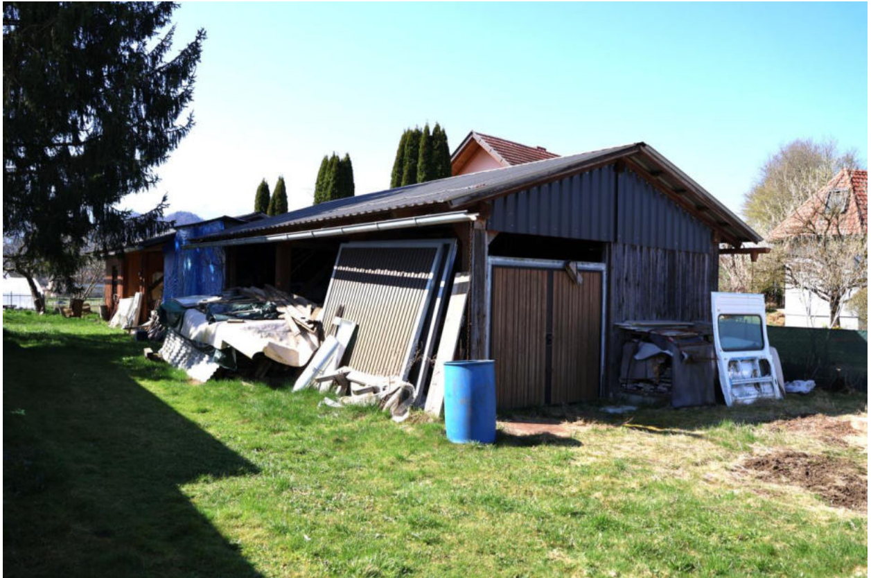
Gebäudeansicht von der Nordostseite mit provisorisch eingebautem Kipptor
