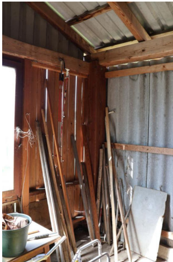
Bild 10 Gebäudeecke Südwest Innenansicht mit verkleideter Holzkonstruktion
