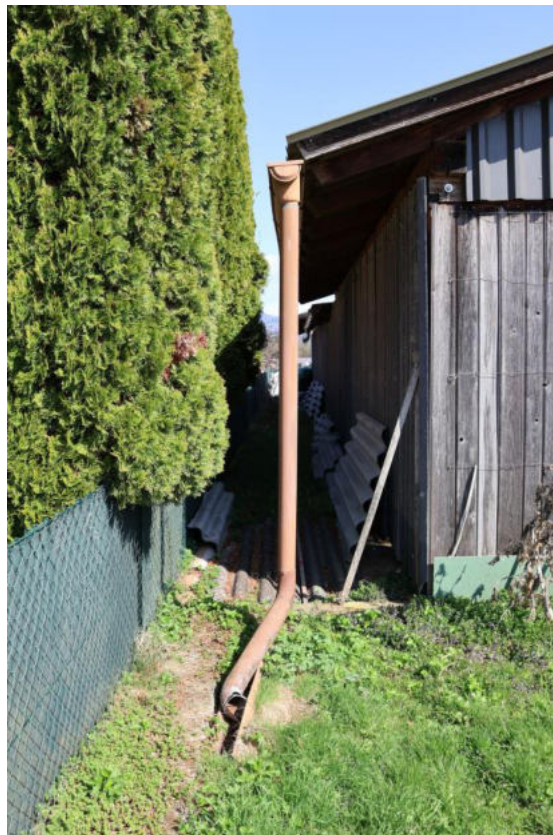
Bild 12 Gebäudeabstand zur westlichen Grundgrenze mit Dachentwässerung als frei auslaufendes Regenabfallrohr
