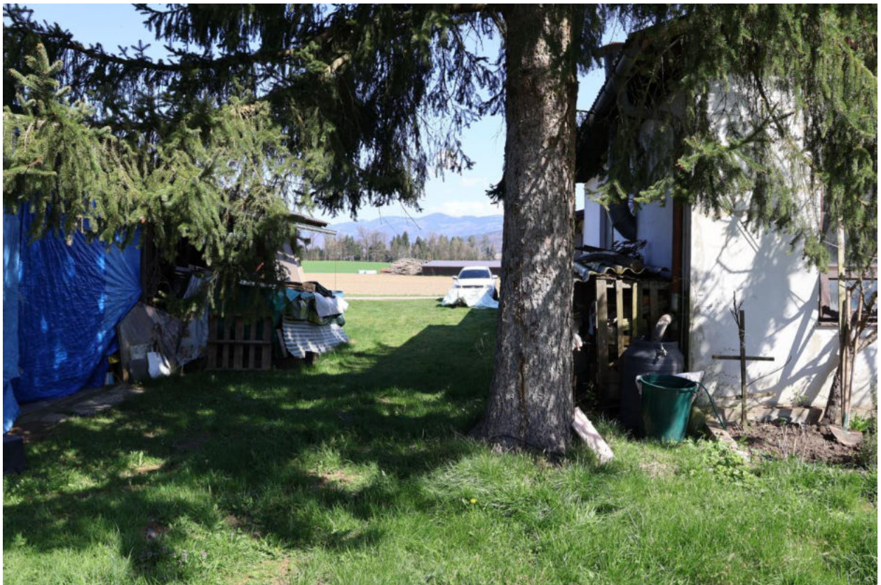
Bild 24 Grundgrenze Ostseite zum Tischlereigebäude im Bereich der Fichte ca. 1,5 m vom Gebäude entfernt
