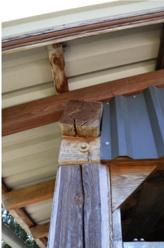
Bild 19 Mauerbank Nordostecke mit Holzsteher
