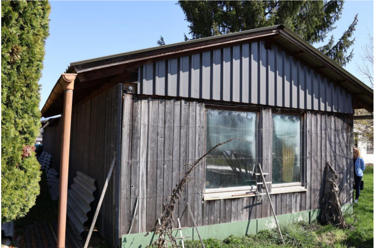
Bild 11 Gebäudeansicht Südwestseite mit Fensterelement
