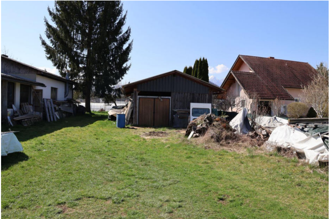
Bild 1 Gebäudeansicht von der Nordseite
