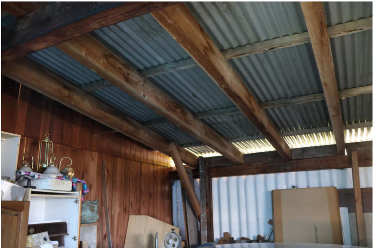
Bild 16 Zwischentrakt mit Pultdach und Wellblecheindeckung
