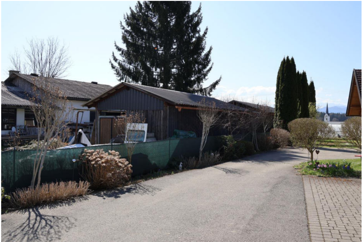
Bild 3 Gebäudeansicht von der Nordwestseite
