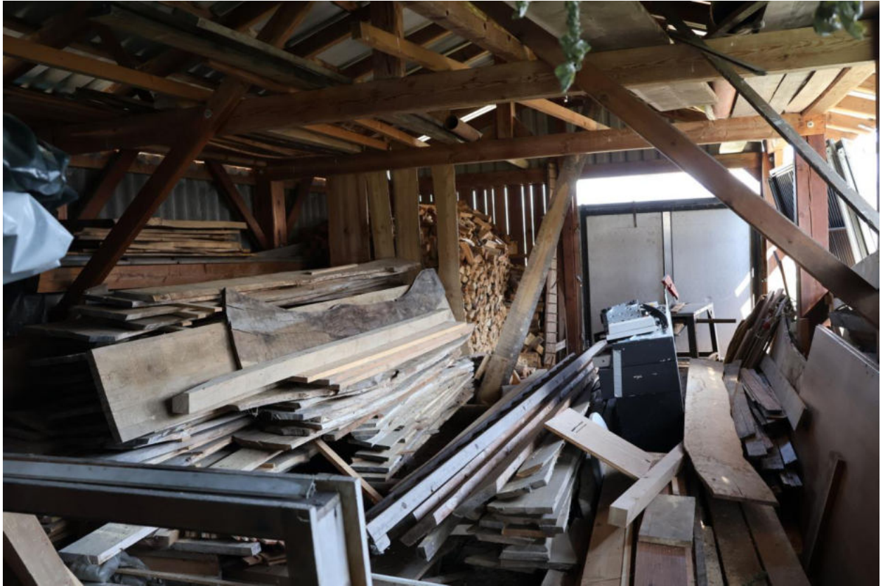
Bild 17 Holzlager Nordtrakt Innenansicht
