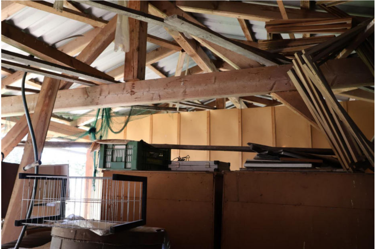
Bild 15 Dachkonstruktion mit Trapezblecheindeckung
