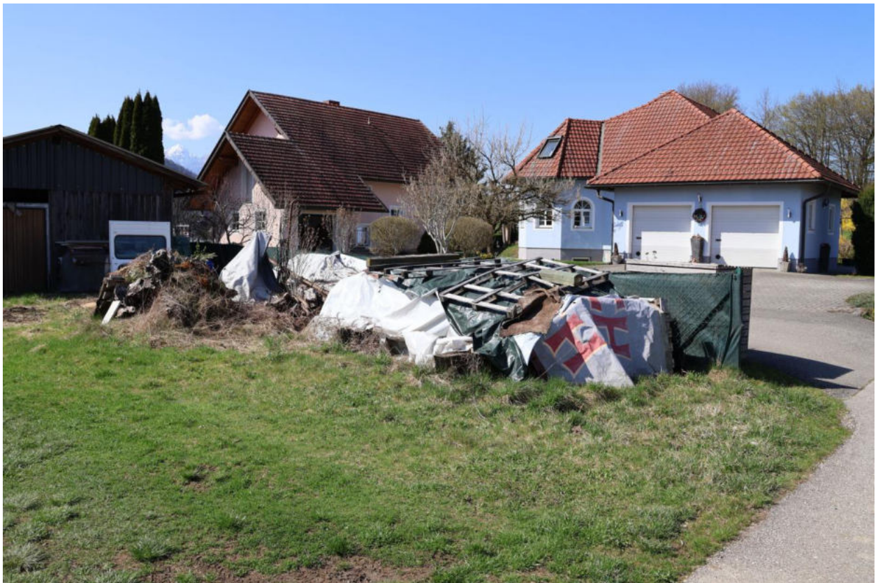
Bild 2 Sperrmüll- und Baumaterialablagierung an der Nordwestseite im Bereich der Zufahrt
