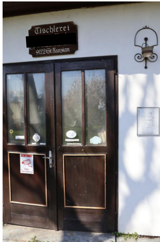
Bild 11 Zugang Maschinenraum Ostseite
