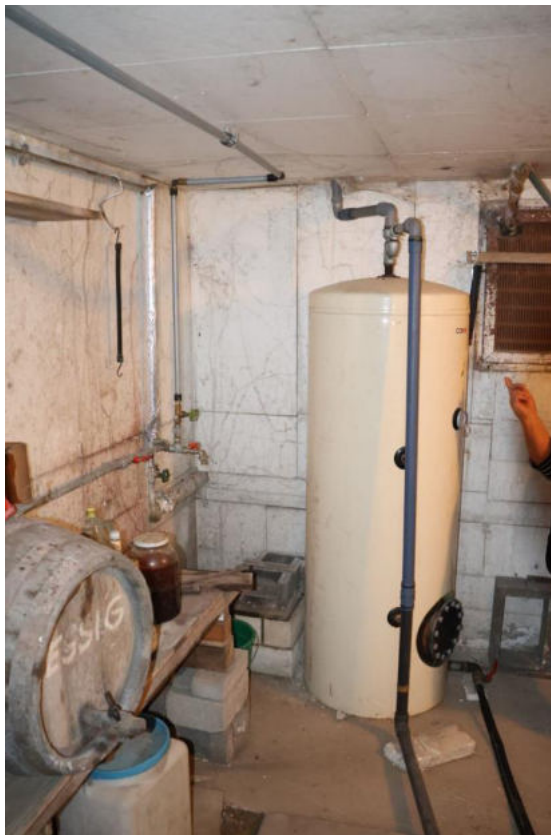
Bild 32 KG Warmwasserboiler
