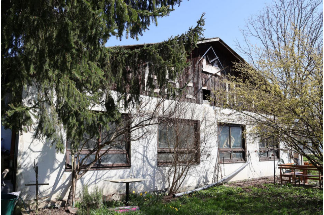
Bild 5 Gebäudeansicht Südseite vom Werkstättentrakt
