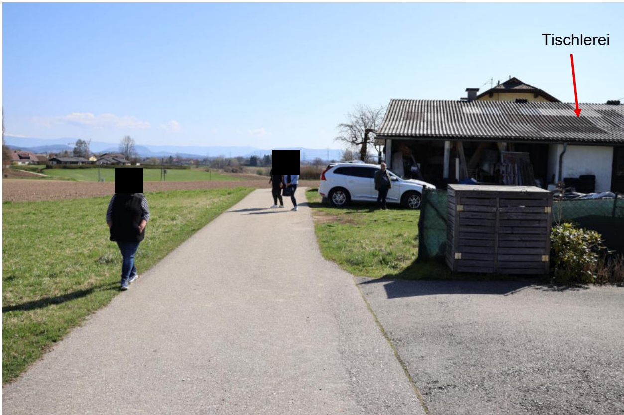
Bild 43 Nördliche Zufahrtsstraße mit Tischlereigebäude
