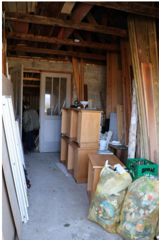
Bild 18 Durchgang zum Maschinenraum 2 von der Nordseite
