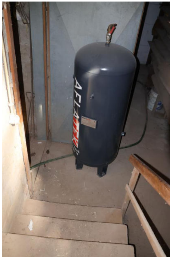
Bild 28 Stiegenabgang in den Keller
