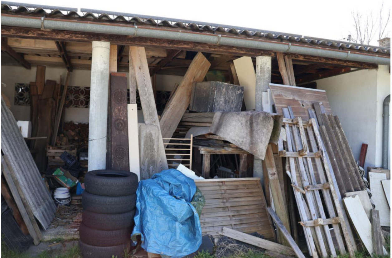
Bild 41 Offenes Bretterlager an der Nordwestseite des Gebäudes
