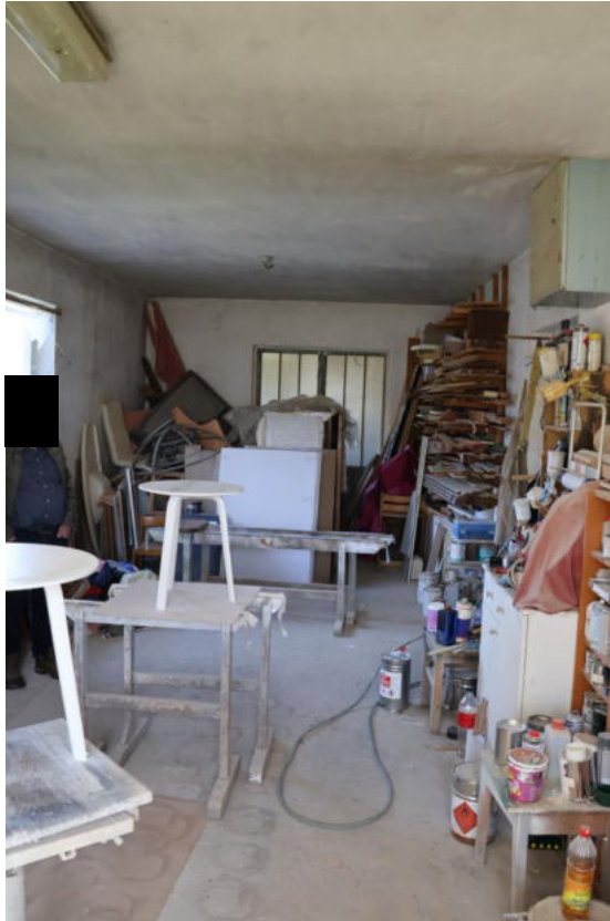
Bild 13 Innenansicht Maschinenraum 3 – genutzt als Lackierraum
