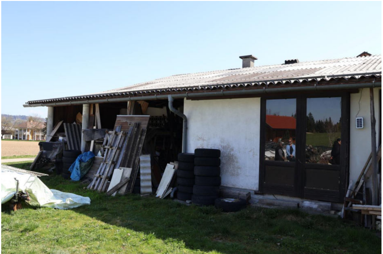
Bild 7 Gebäudeansicht Bretterlager Westseite
