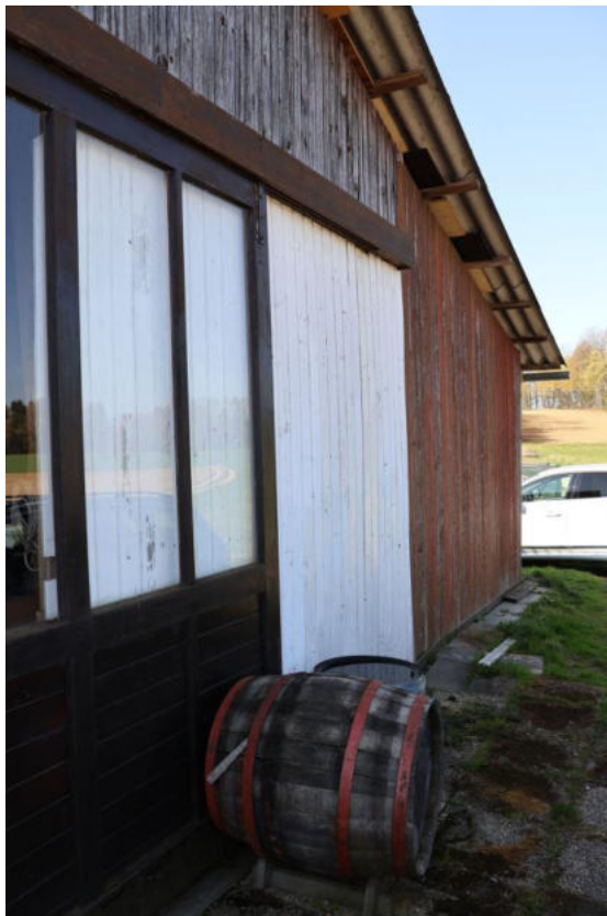
Bild 40 Schiebetor an der Nordseite
