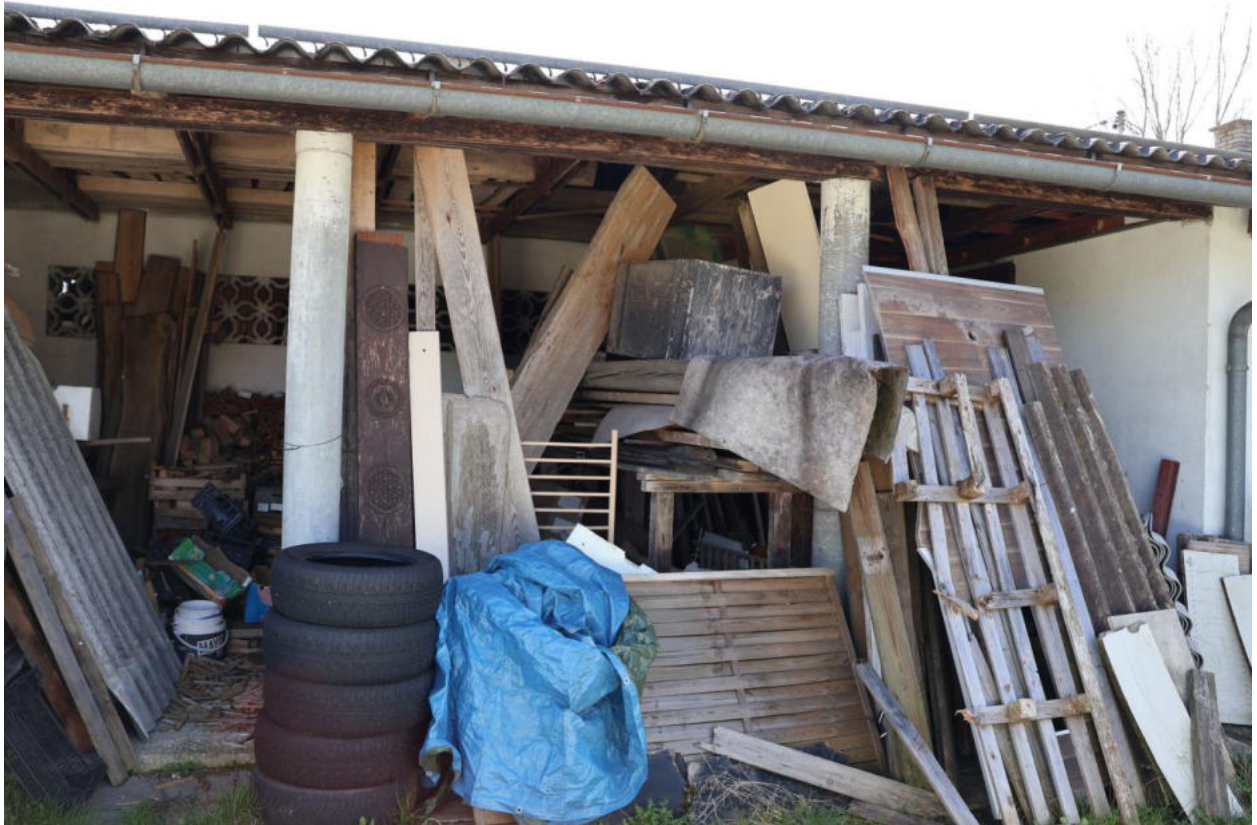
Offenes Bretterlager an der Westseite
