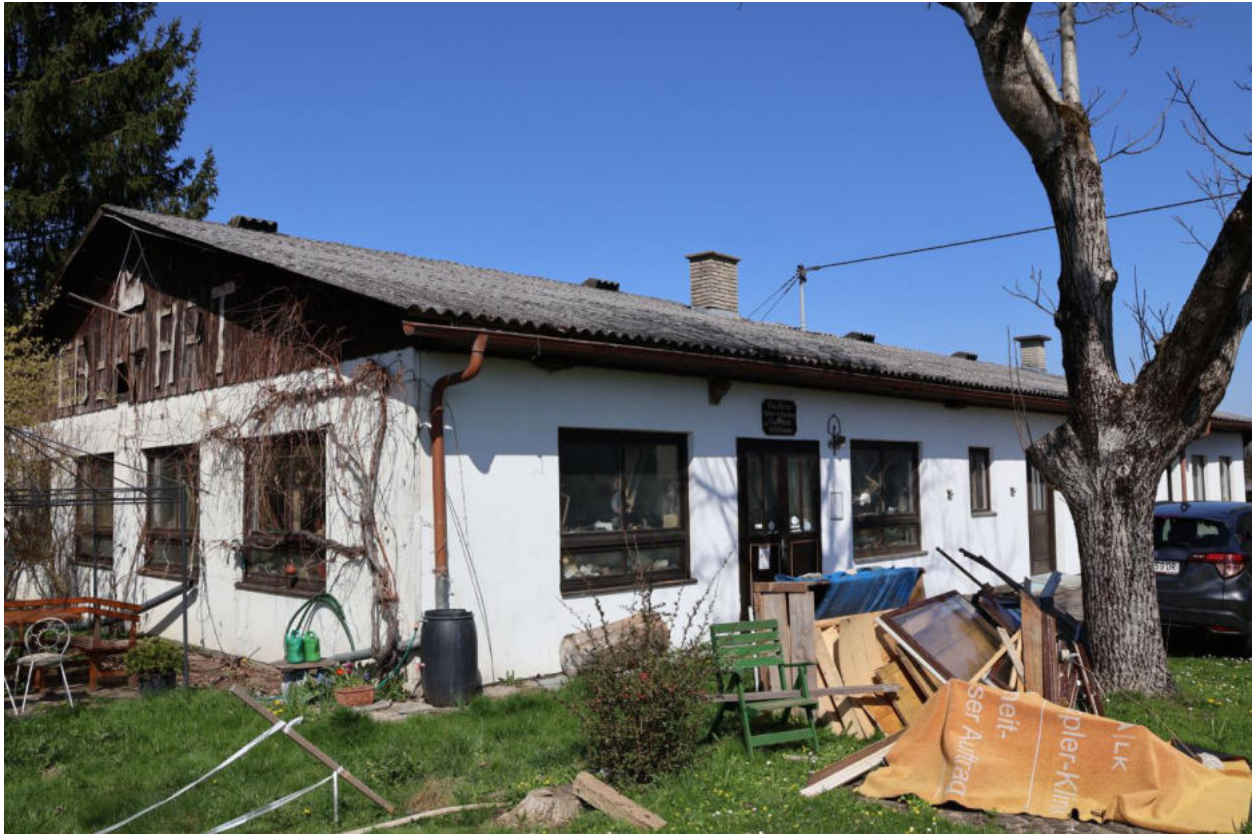
Gebäudeansicht von der Südostseite mit Zugang zur Werkstätte
