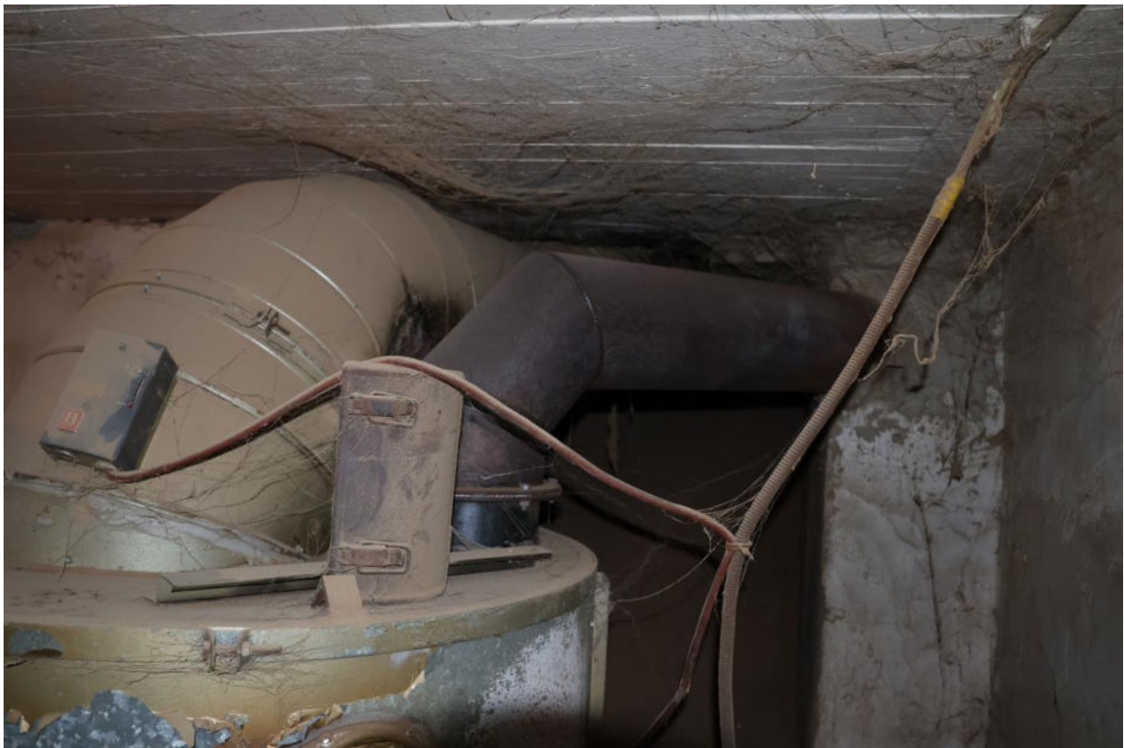
KG Heizkessel mit Rauchrohr und Heißluftkanal
