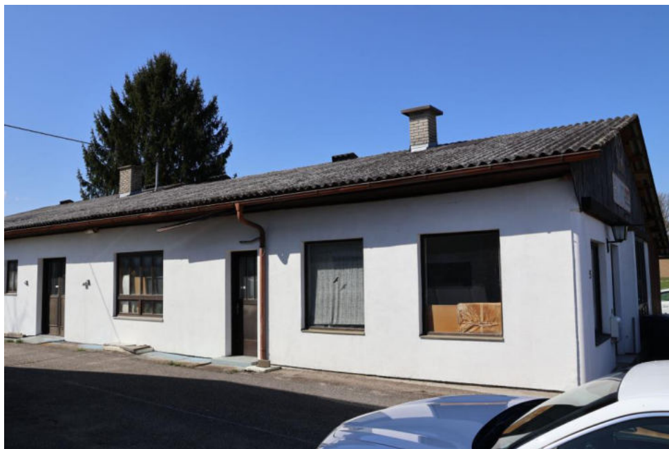
Gebäudeansicht von der Nordostseite
