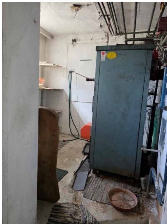
Abbildung 8 ehemaliger Heizraum UG
