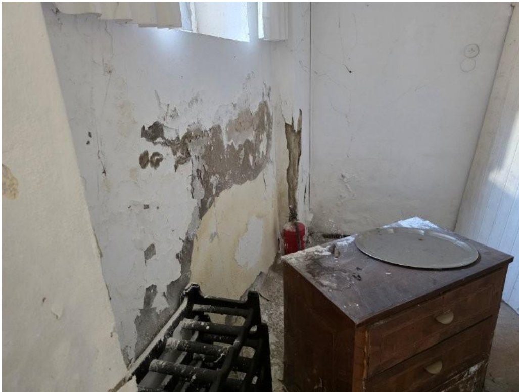
Abbildung 7 Wasserschaden UG
