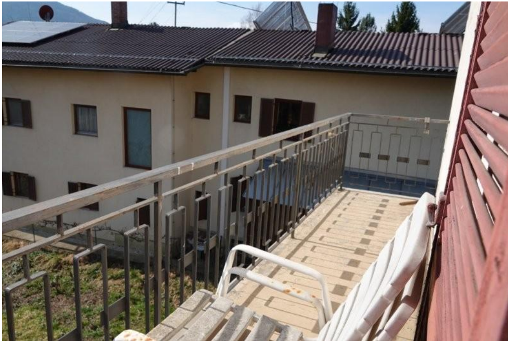
Abbildung 19 Balkon Blick Richtung Westen
