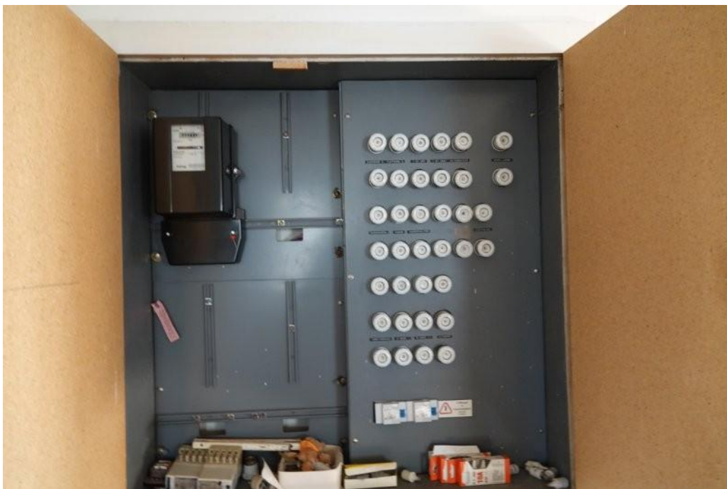
Abbildung 28 E-Verteiler
