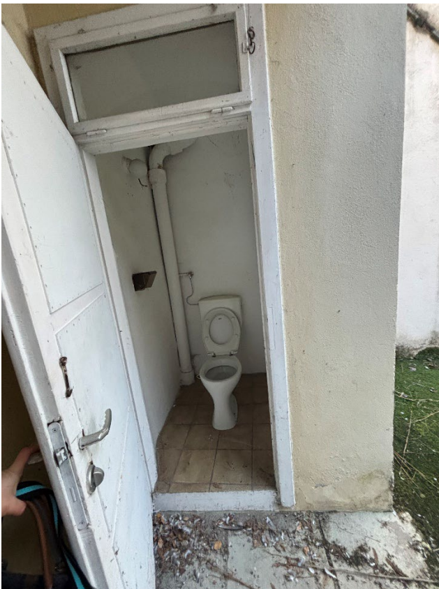
WC im Innenhof
