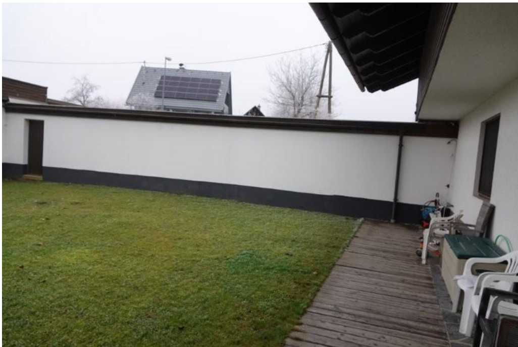
Abbildung 38 Südseite des Laubenganges
