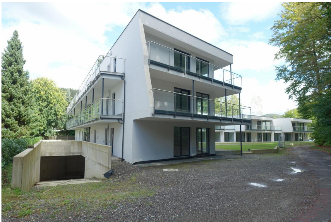
SÜD-WESTANSICHT MIT TIEFGARAGENEIN- UND AUSAHRT - FOTO 1
