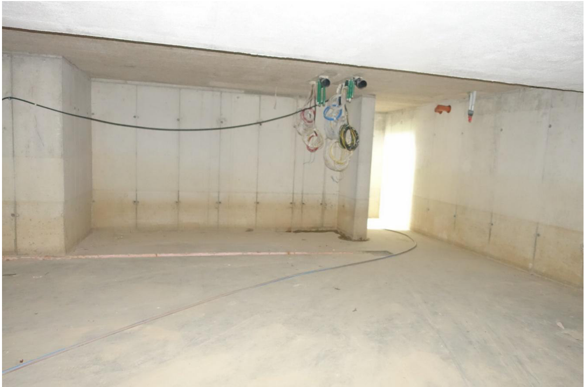
TIEFGARAGE MIT ABSTELLRAUM/AUSSENTREPPE IM NORDEN - FOTO 15
