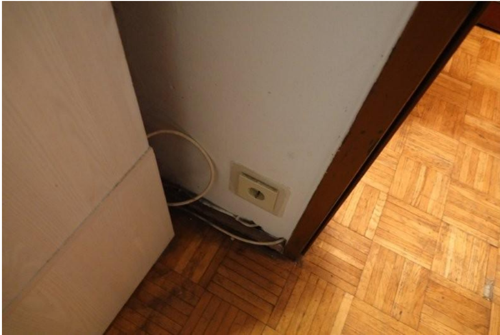
Abbildung 19 Laienhafte E-Installationen
