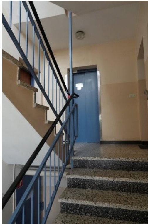
Abbildung 21 Stiegenhaus mit Lift
