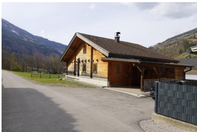
Ansicht von Nordosten
