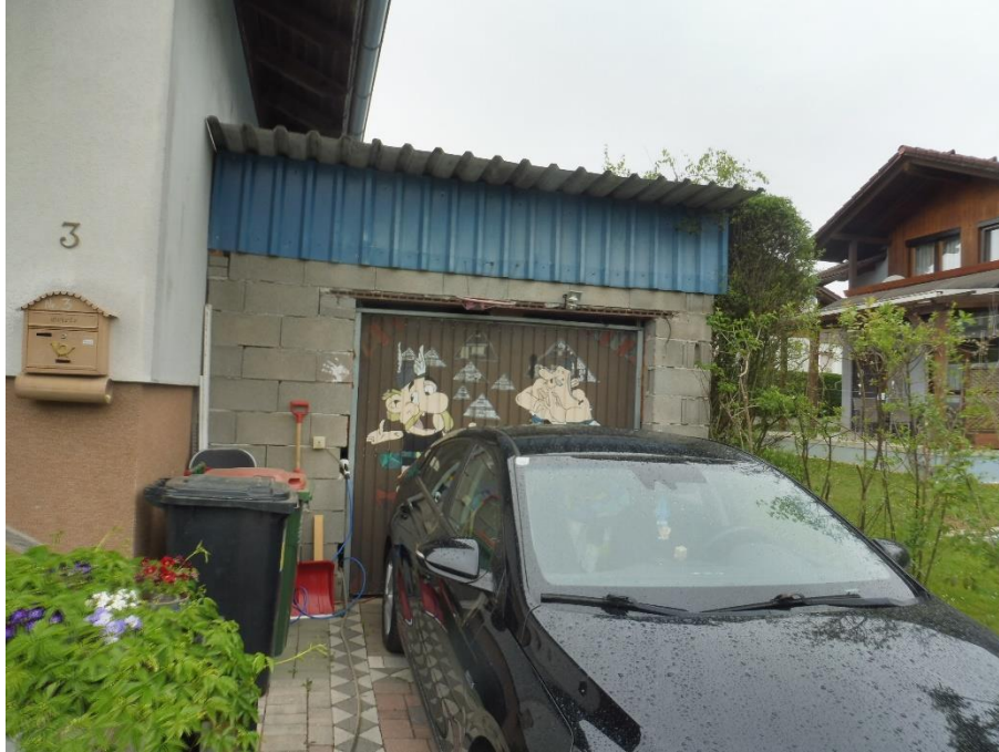
Garagenanbau an der Nordseite
