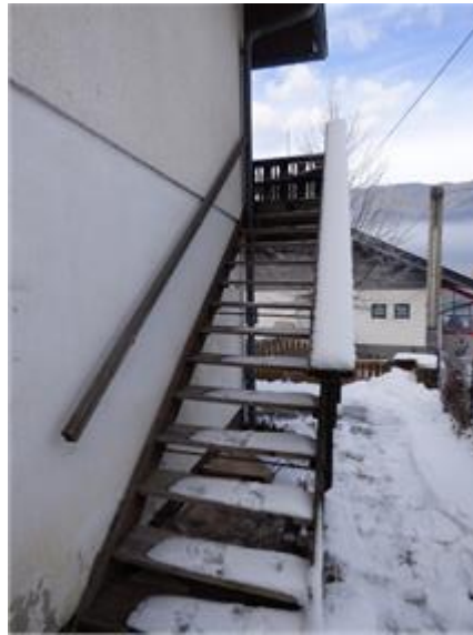
Außenstiege zu Wohnung Top 3
