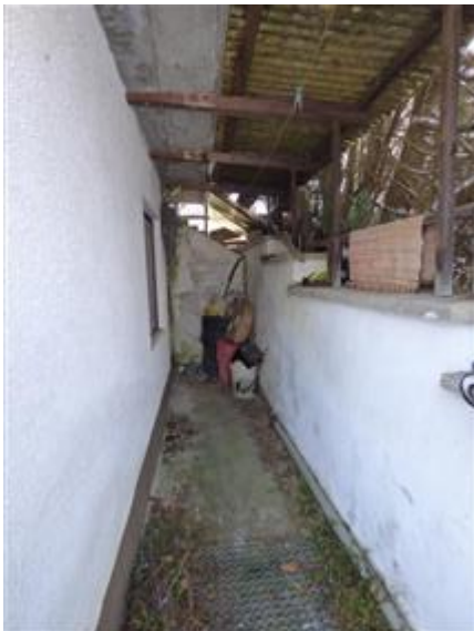
Außenzugang zum Kellergeschoss
