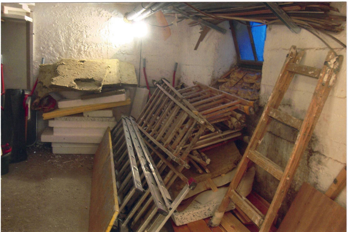
Kellerraum Top 28-2 Nord
