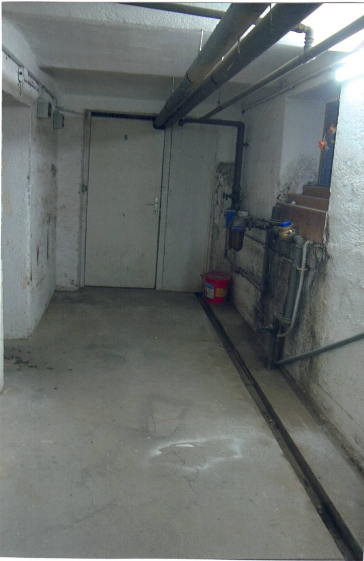
Vorraum zum Kellerraum Top 28-2
