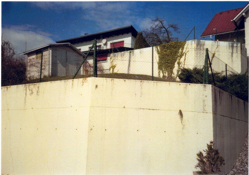
mittlere und untere Stützmauer
