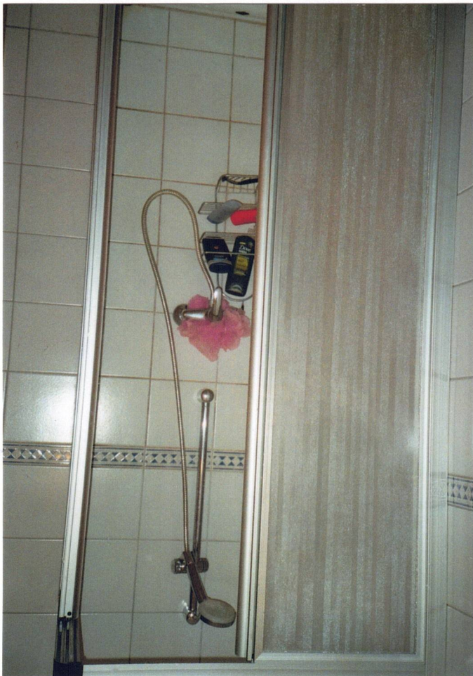
Dusche im Untergeschoss
