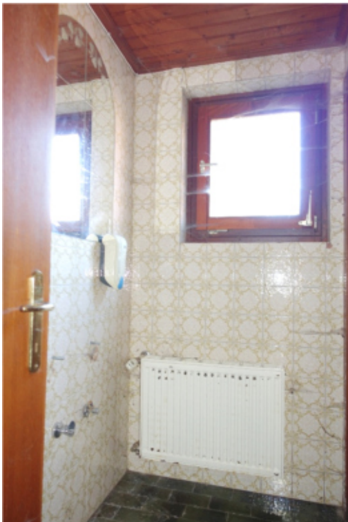
VORRAUM 3/DAMEN-WC - FOTO 178
