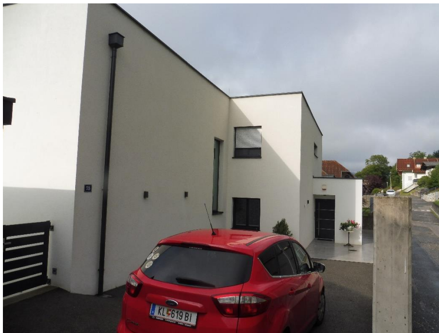
Nordseite und Zugangsbereich (oben)
