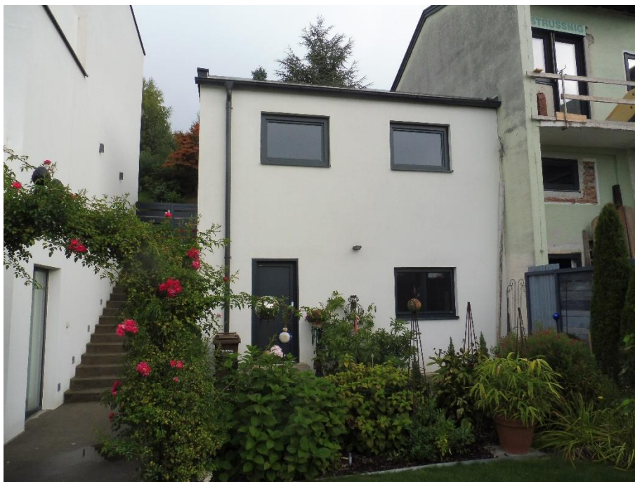
Garagegebäude mit Aufgang zur Straße (oben) Aufgangssteige zwischen Wohnhaus und Garage (unten)
