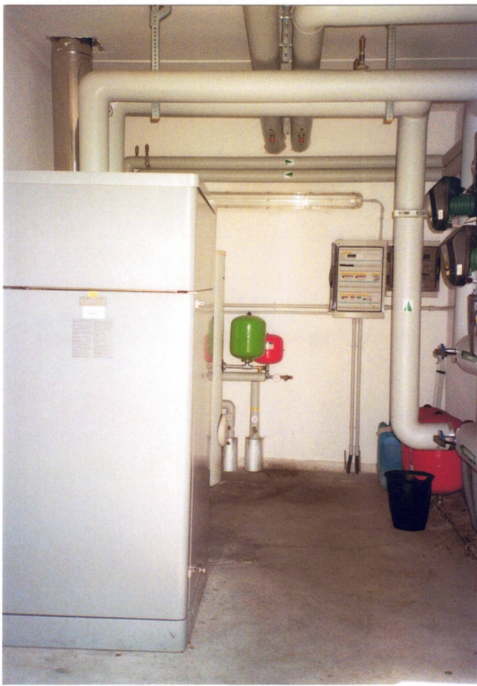
Endgeschoss - östlichen Gebäudeteil - Gastherme mit Boiler
