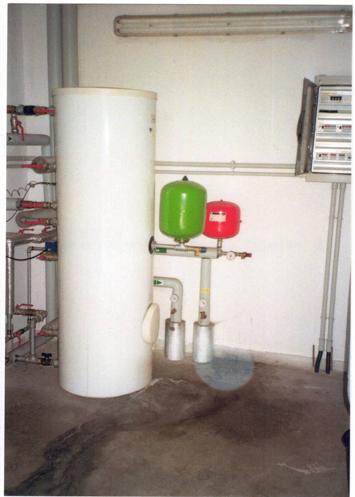
Endgeschoss - östlichen Gebäudeteil - Gastherme mit Boiler
