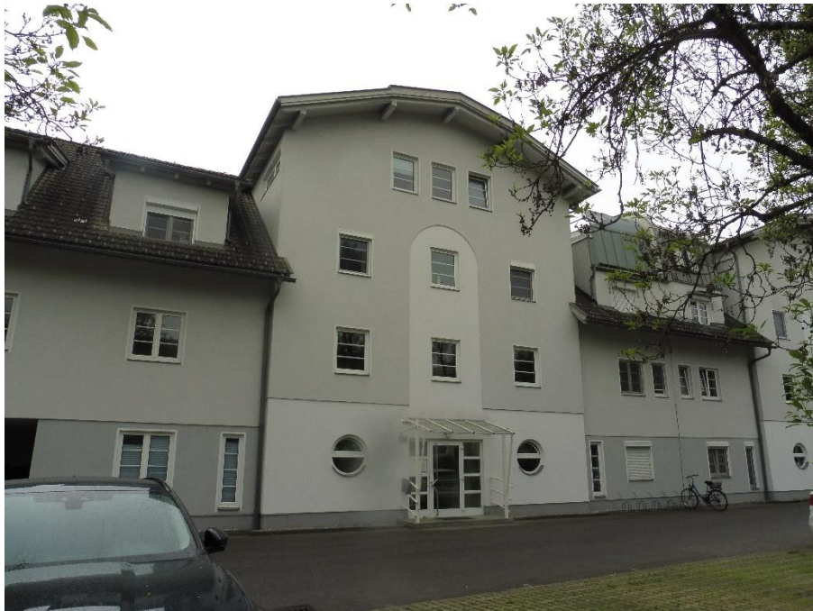
Teilansicht Nordseite Haus I (unten)
