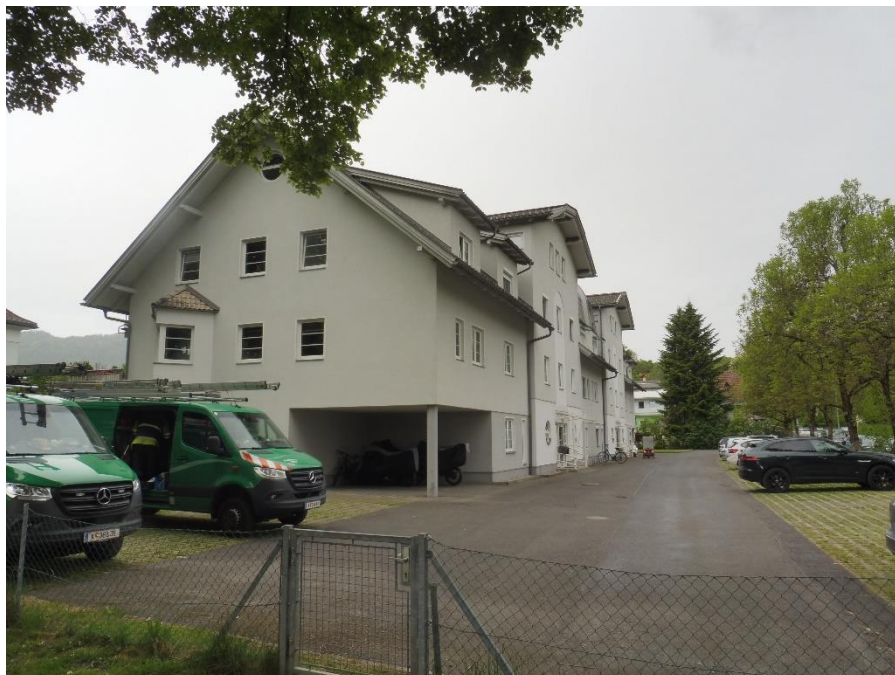
Ansicht Ost- und Nordseite (oben)
