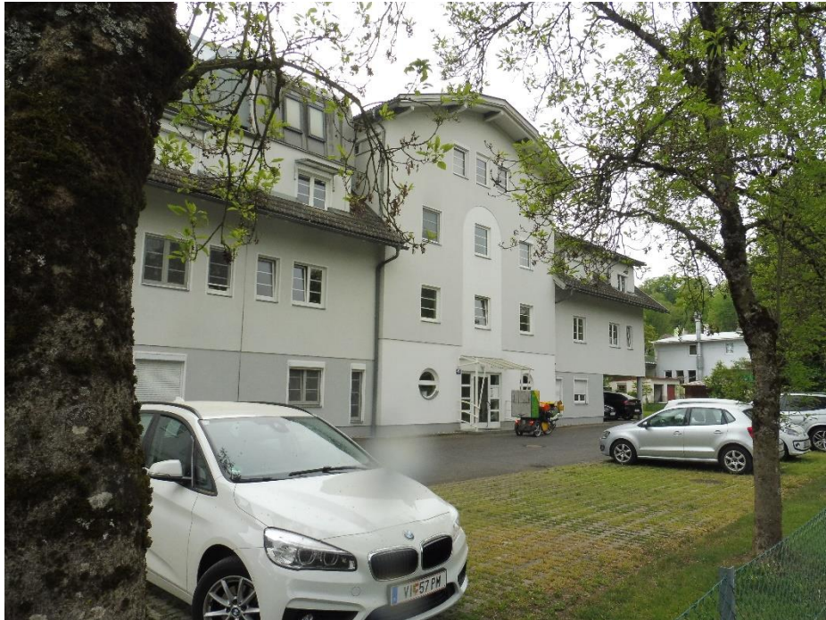
Teilansicht Nordseite Haus II (oben)
