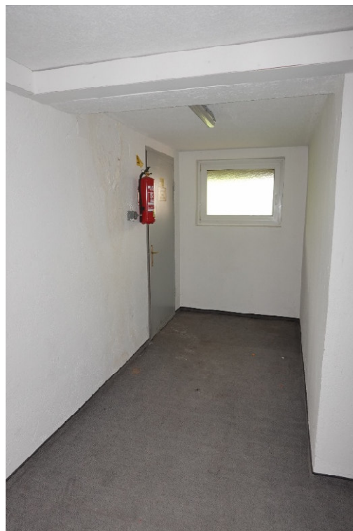
VORRAUM 2/RICHTUNG HEIZR. - FOTO 15
