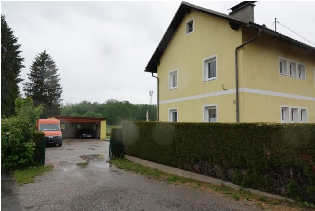
Abbildung 49 Ostansicht und Zufahrt zur Garage
