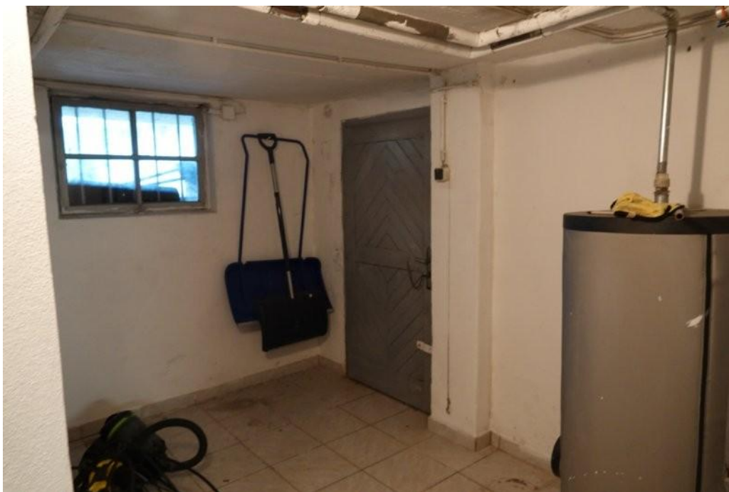
Abbildung 4 Ausgang in den Garten vom Heizraum aus
