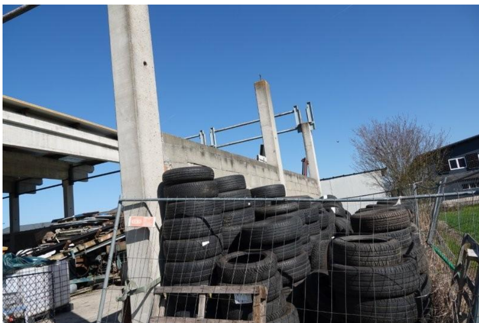
Abbildung 22 Lagerhalle Ost Ansicht
