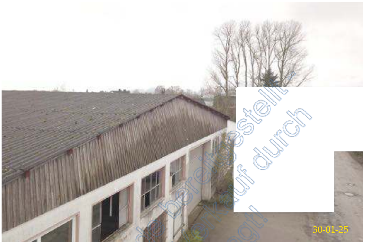
Detailansicht-Giebeldreieck Gewerbehalle Giebeldreieck nach innen geneigt
