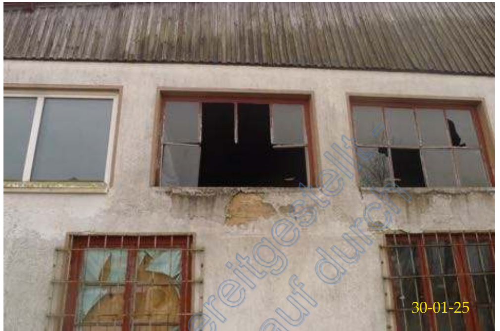
Giebel Gewerbehalle von Nord-Osten starke Putzschäden, Fenster stark beschädigt
