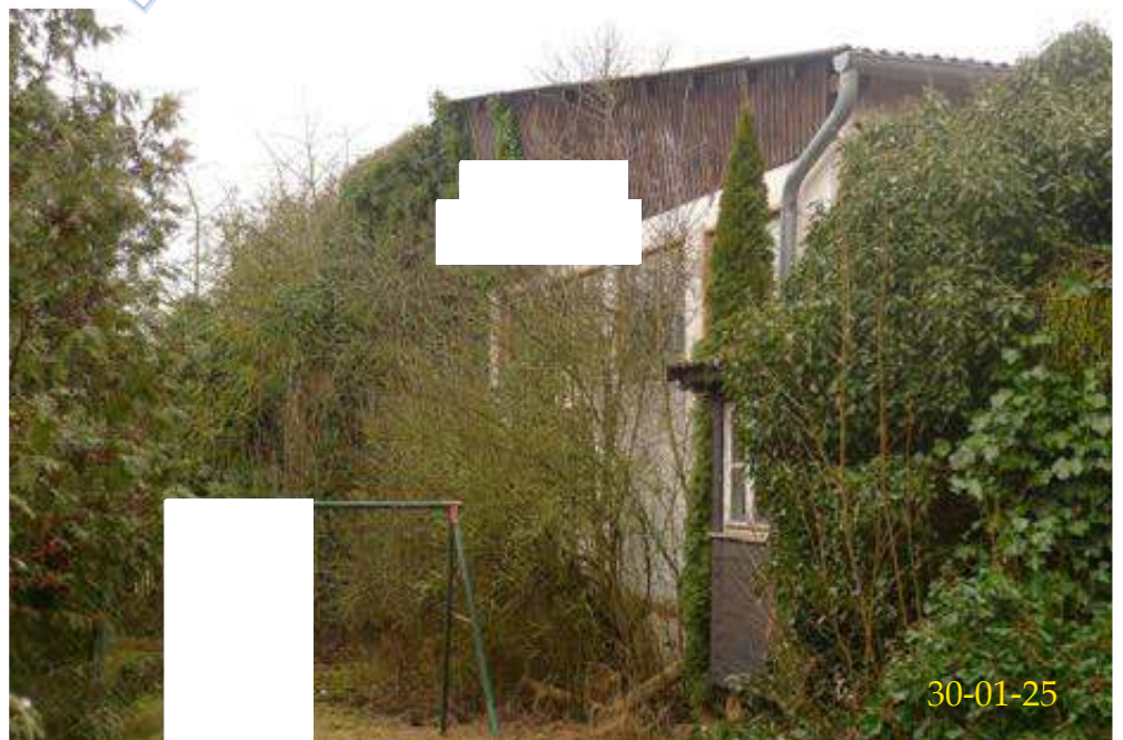
Giebelfassade Gewerbehalle von Süd-Osten Giebel dreieck nach außen geneigt
