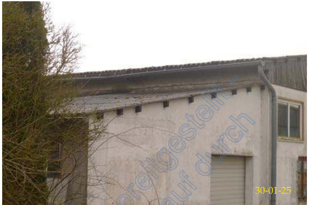
Detail Dachentwässerung Dachrinne stark wellig Putzschäden an der Außenwand
