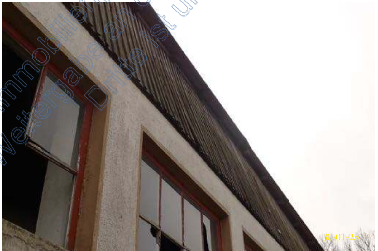
Detailansicht-Giebeldreieck Gewerbehalle Giebeldreieck nach innen geneigt
