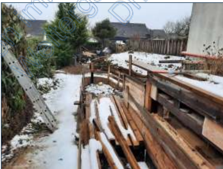
Abb. 6: begonnene baulichen Maßnahmen auf Fläche mit Sondernutzungsrecht von Nr. 3
