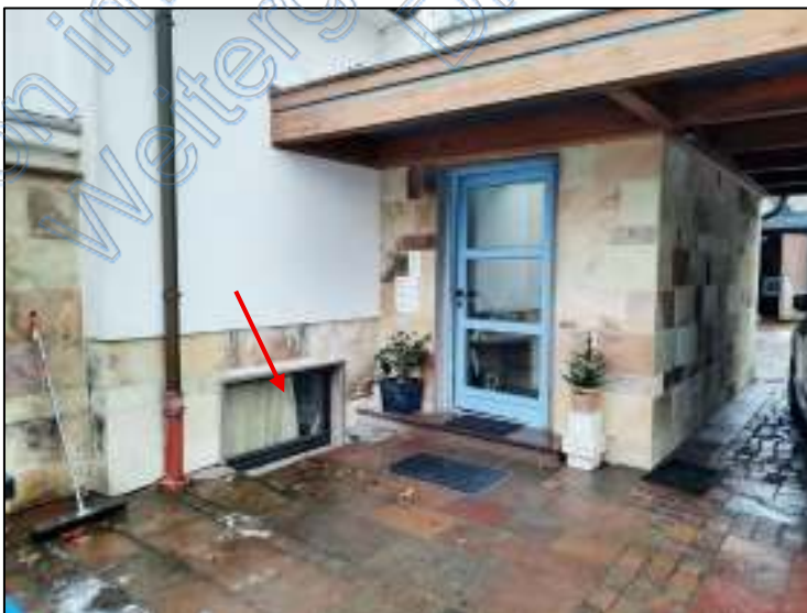
Abb. 3: Hauseingang; links (Pfeil) Küchenfenster
