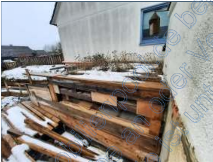
Abb. 5: Ansicht Ostseite mit überdachtem Freisitz zu Nr. 3 und begonnenen baulichen Maßnahmen auf Fläche mit Sondernutzungsrecht von Nr. 3
