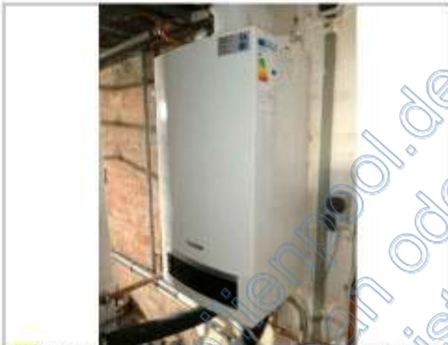
Bild 25: Kellergeschoss | Brennwert-Gastherme Fabrikat Buderus GB 17214, Baujahr 2019
