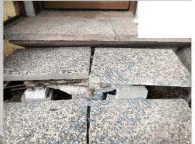
Bild 6: Eingangstreppe | defekt
